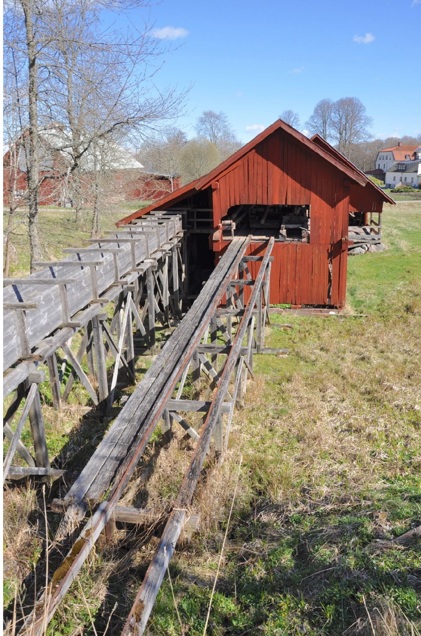
Gamla ränna och rampen. Före åtgärd och rivning. Inget mer än järnbeslag och delen av vattenrännan under taket över hjulet gick att återbruka.
