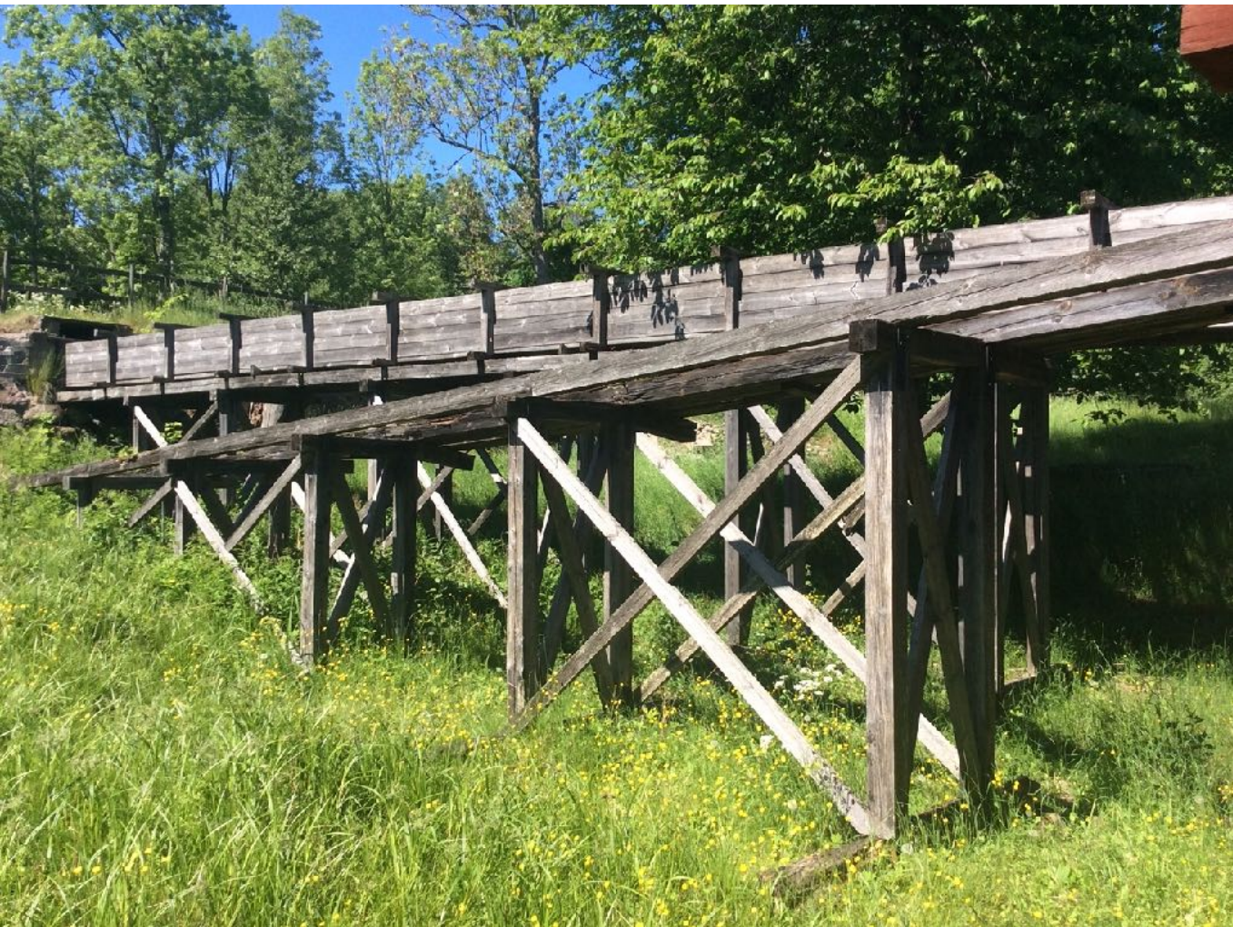
Gamla ränna och rampen. Före åtgärd och rivning. Inget mer än järnbeslag och delen av vattenrännan under taket över hjulet gick att återbruka.
