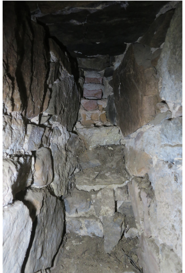
Det nedre av de tre igenmurade ljusgluggarna i korgaveln doldes tidigare helt av isoleringen. Igenmurningen har möjligen skett redan under medeltiden.
