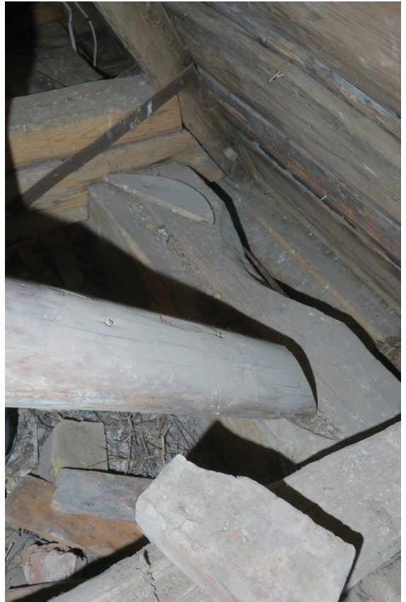
Rundstock kilad mellan högben i söder och rem i norr, tar mycket tryck.
