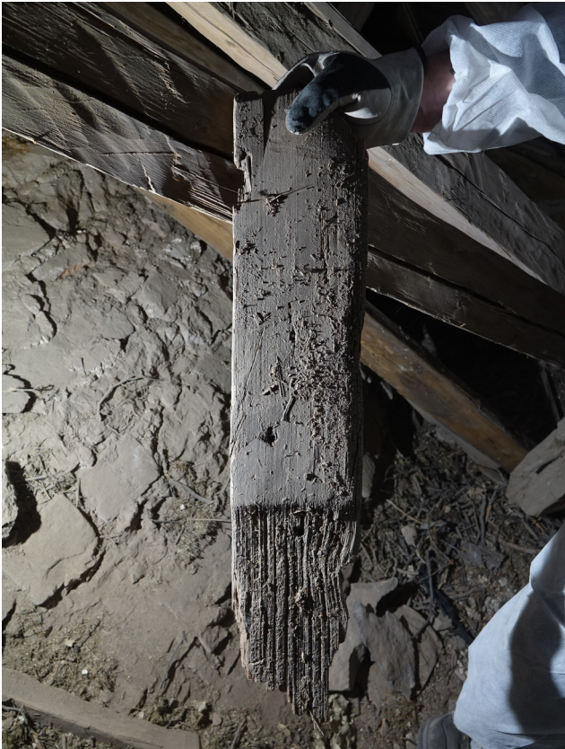
Fynd av hugget takspån av furu med kraftigt nött bleke och rester av rödtjära.
