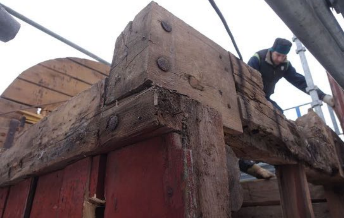
Den äldre ekstocken som håller lagerstenen. Den har en uthuggen fals 1,5" bred och djup tillverkad genom att borra med skednavare i rad och sedan hugga rent. Liknande har jag sett i Skåne på medeltida klockstaplar, tex Perstorp/Brönnesta.
