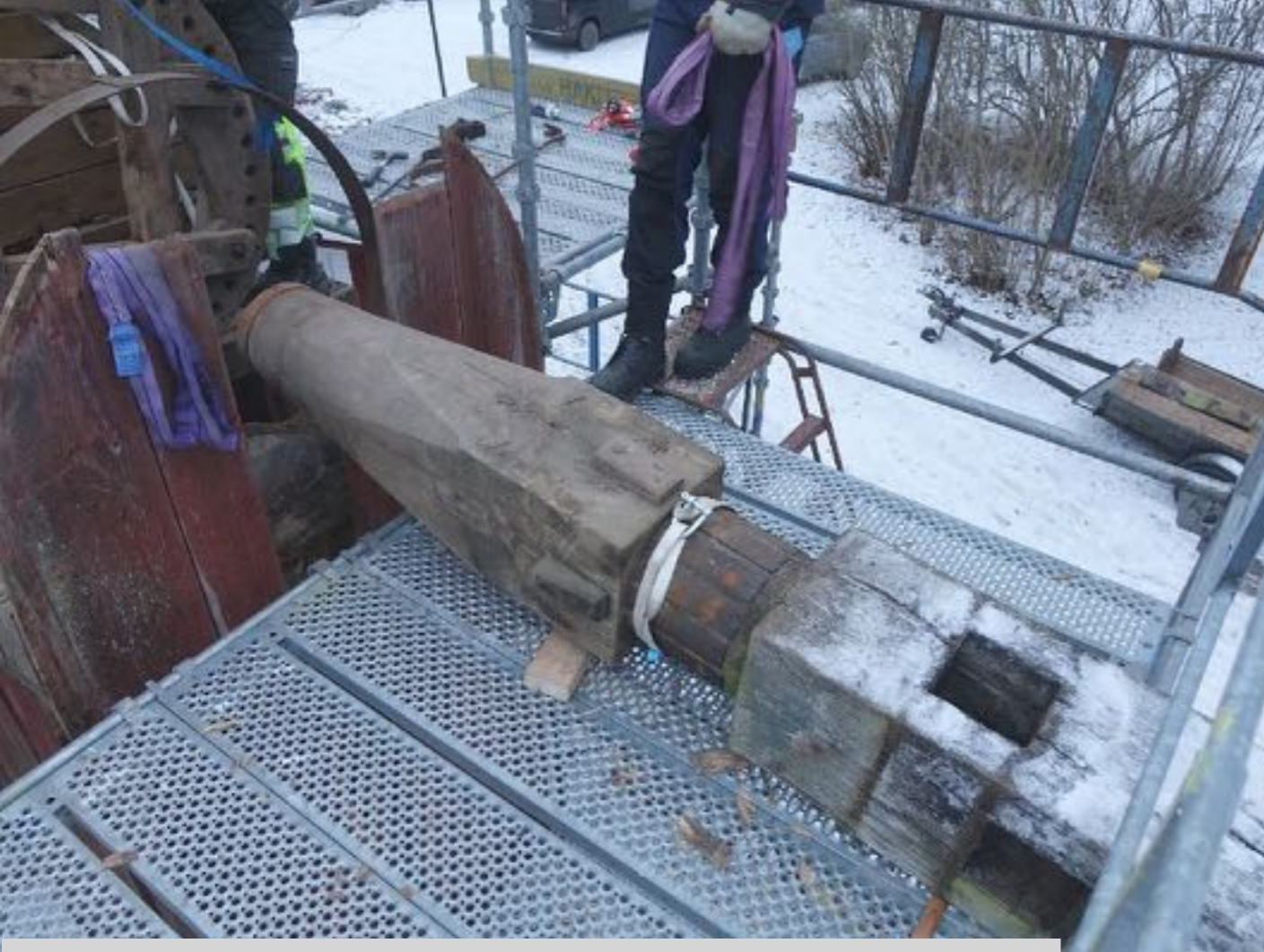
Vingaarna var skarvade i vingaxeln såhär. Enligt äldre foto från Söne har det varit balkar och 4 st lösa vingar.
