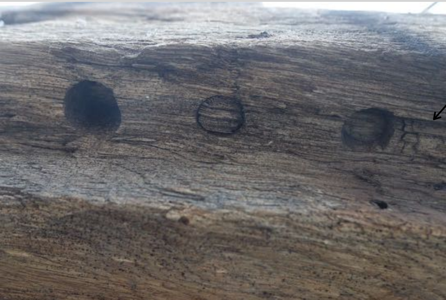
Den äldre ekstocken som håller lagerstenen. Den har en uthuggen fals 1,5" bred och djup tillverkad genom att borra med skednavare i rad och sedan hugga rent. Liknande har jag sett i Skåne på medeltida klockstaplar, tex Perstorp/Brönnesta.
