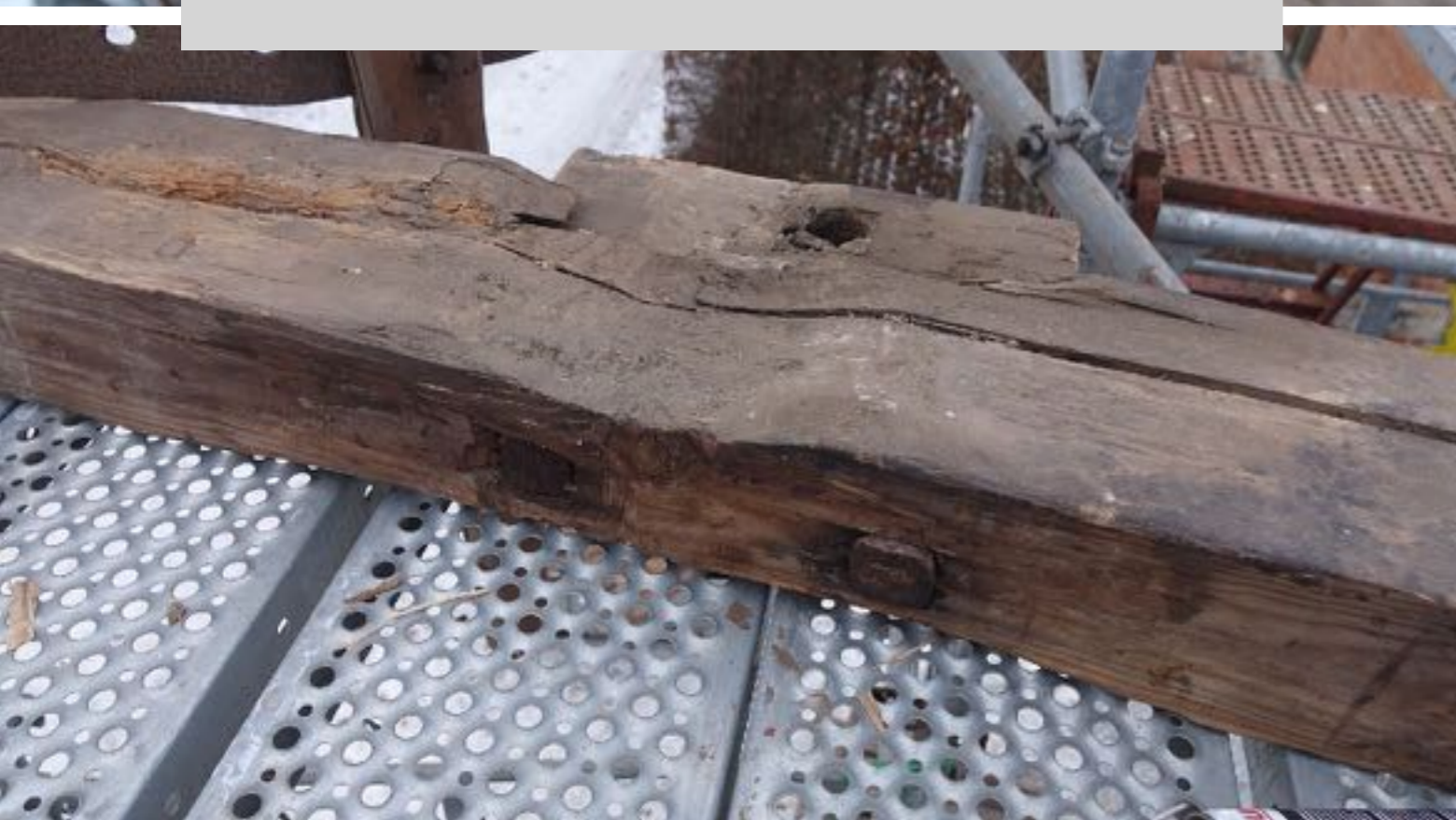
Lagerbalken för drivaxelns övre lager.
