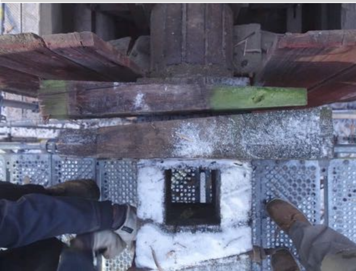
Vingaarna var skarvade i vingaxeln såhär. Enligt äldre foto från Söne har det varit balkar och 4 st lösa vingar.
