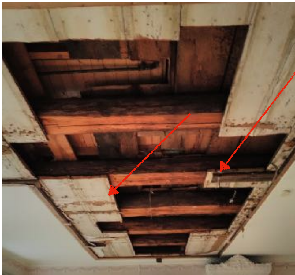
Innertaket vid mitt första besök i Prästgården. Bjälkar i gott skick. De små bitarna i mitten (röd markerade) av skadan tog vi bort för att kunna utföra lagningar med långa längder. Alla skarvningar utfördes på bjälkarna. Observera att spikning skett med tre spikar i varje bräda.
