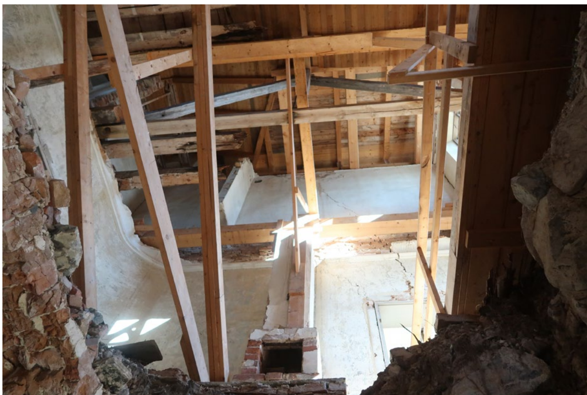
Fotografi mot öster genom bjälklagshålet, från rum 104 upp mot 205. Den murade spisen står intill östra väggen i rum 205. Vid seminariet föreslogs en ny hög ståpelare från golvnivå i rum 104 upp till takkonstruktionens balkar.
