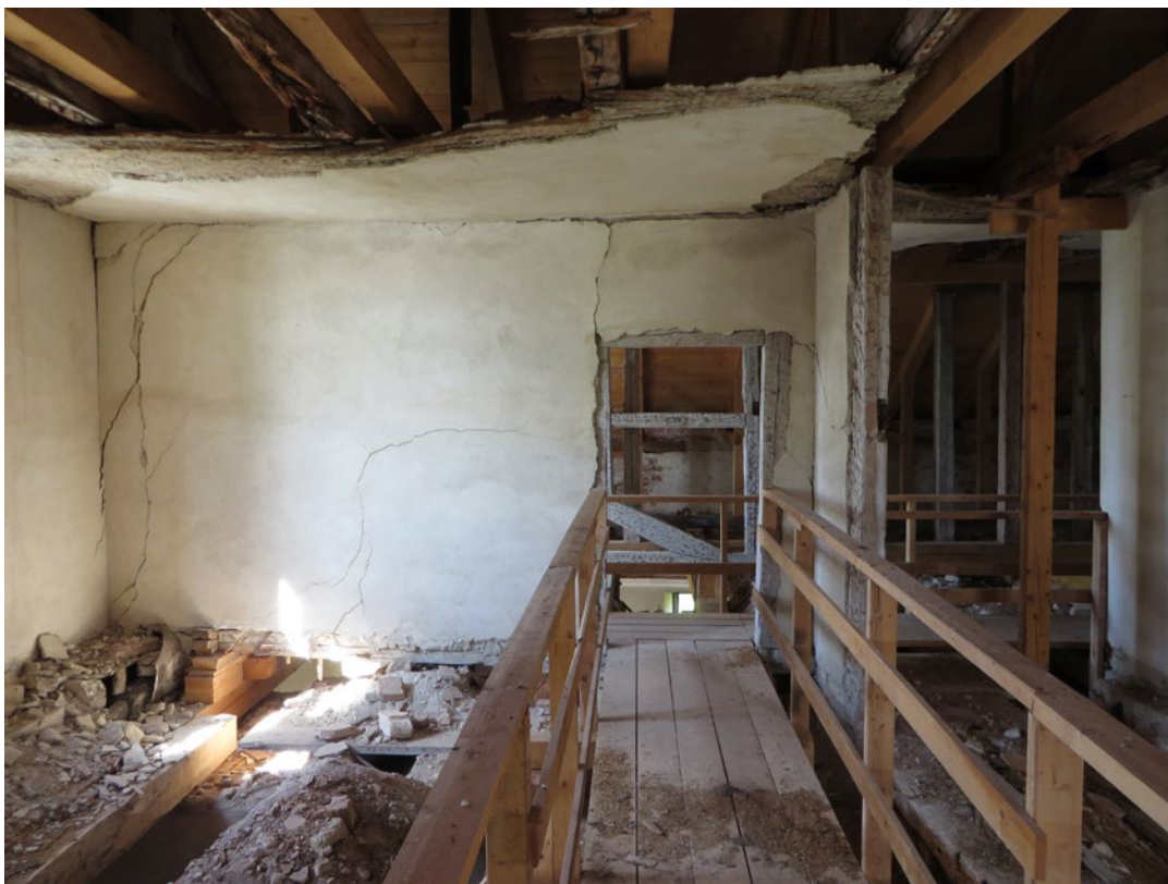
Fotografi från rum 311-314. Till vänster skymtar en del av de lösa rasmassor och bjälklagsfyllningar som fortfarande ligger kvar och belastar byggnadskonstruktionen.
