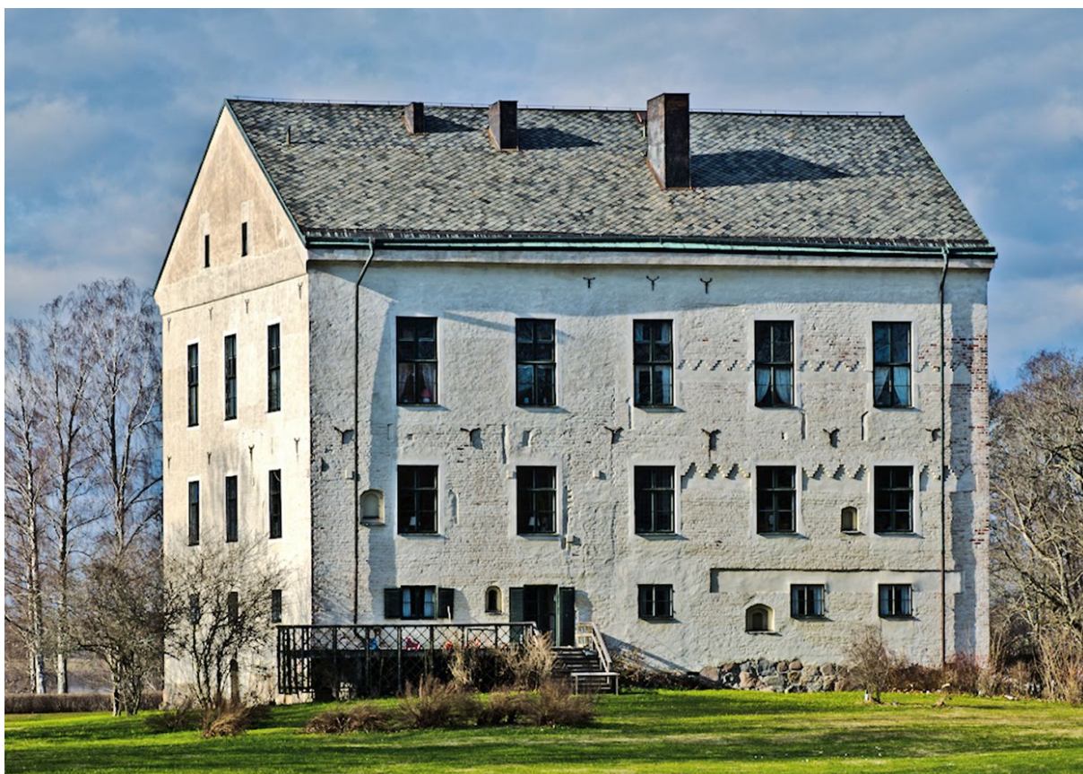
Göksholms slott på en udde vid sjön Hjälmarén öster om Örebro. Slottet är den enda byggnad i Sverige som varit kontinuerligt bebodd sedan medeltiden.
