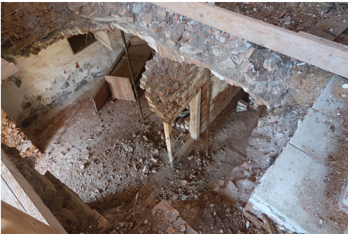
Hålet i bjälklaget över bottenvåningen sett från spången i rum 205 på övervåningen.
