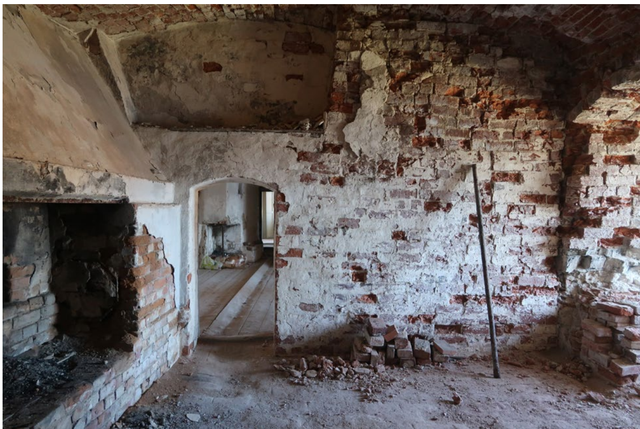
Rum 112. Dörröppningen går till rum 111. Tegelvalvet och mellanväggen har stora skador. Den övre bilden visar taket i rum 112.
