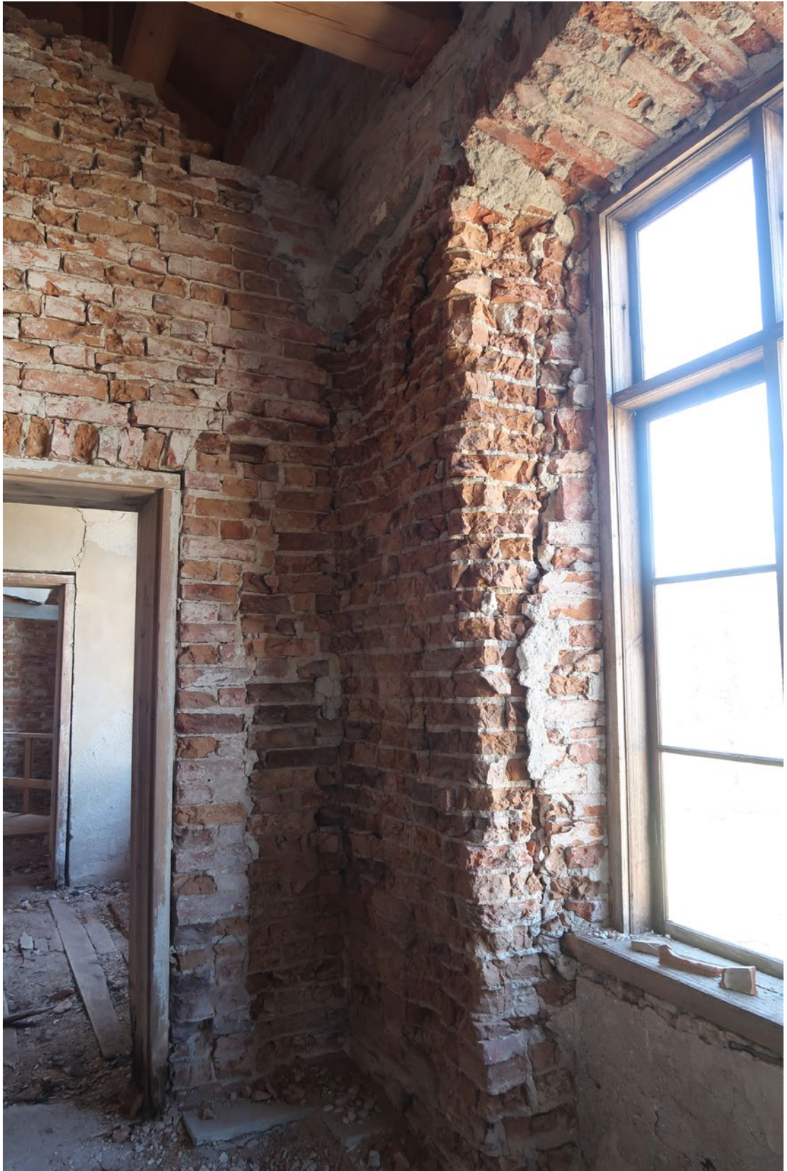
Rum 210. Ytterväggen intill fönstret är vittrad och har en lång vertikal spricka. Samtidigt belastas den av balken som syns i bildens överkant.
