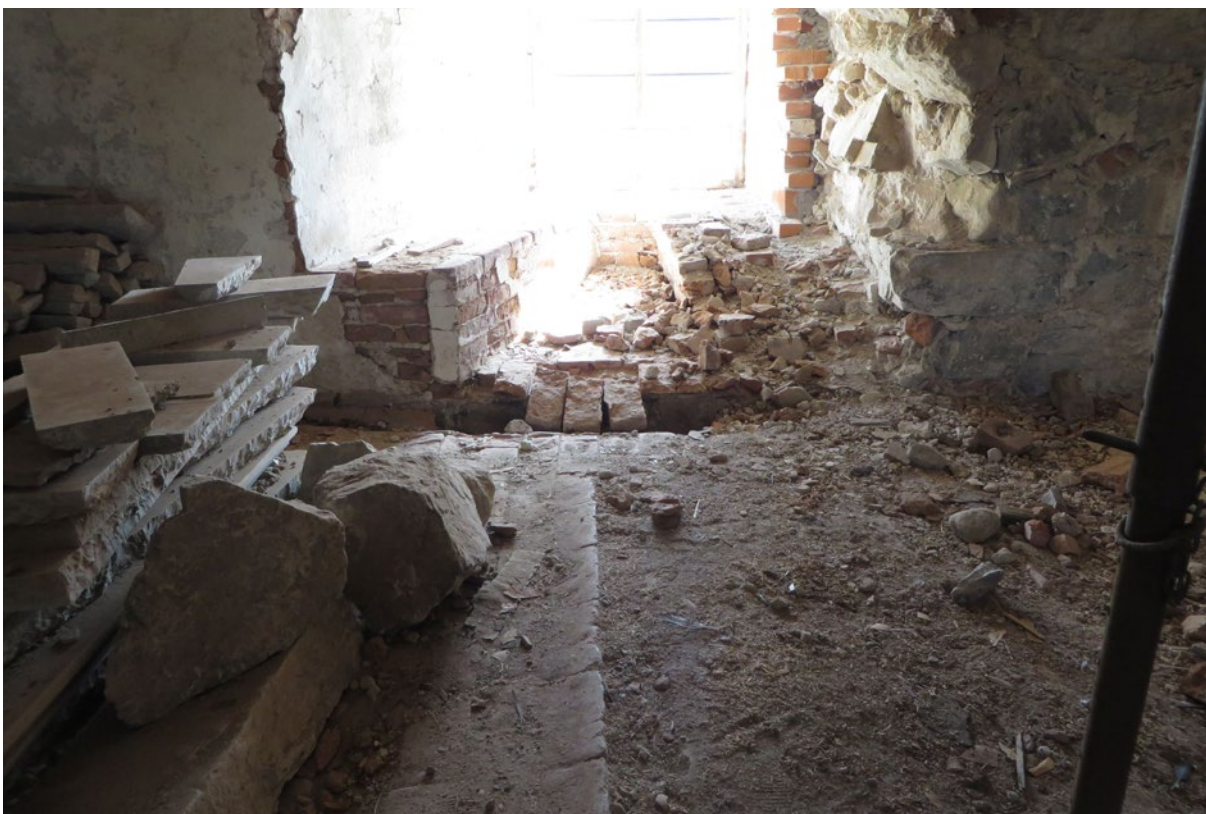
Rum 104. Närbild av skadan i bjälklaget mellan källaren och bottenvåningen.
