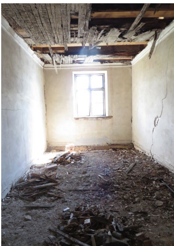
Rum 310. Fotografi mot söder. Väggen till höger i bild ligger över rum 208.
