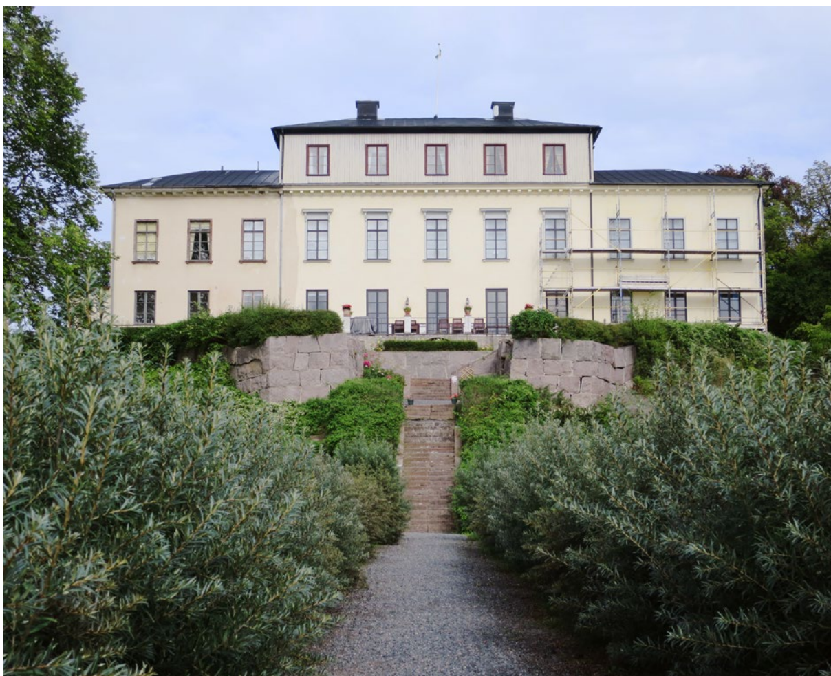
Casimirsborg, Gamleby socken. Den nuvarande huvudbyggnaden från 1829 innehåller rester från två tidigare byggnadsetapper.
