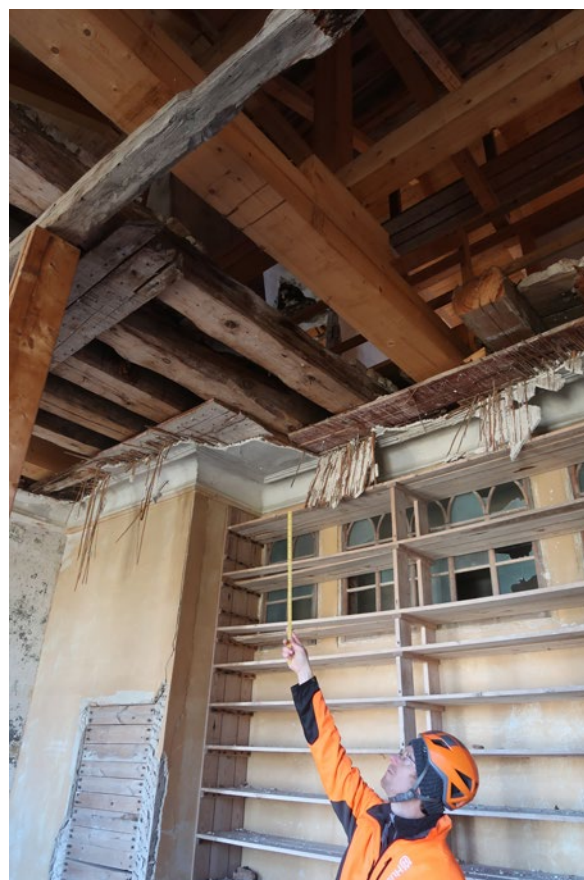
Mattias Hallberg pekar på den punkt under den befintliga långstolen där pelaren bör ansluta.
