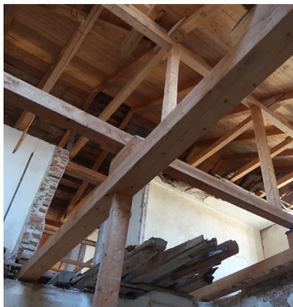
Stötтан tar tyngd från det södra takfallet.
