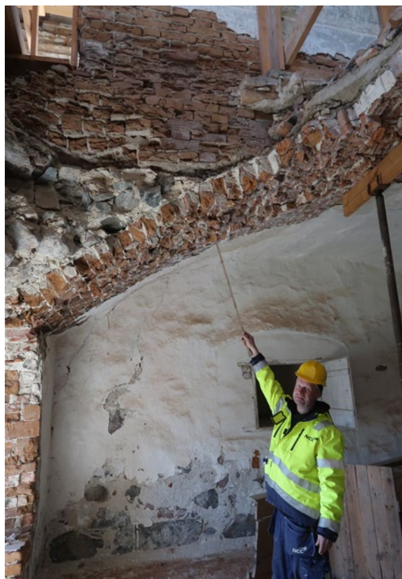
Johan Berglund, smed och murare, föreslår en förstärkning av det skadade takvalvet över rum 105. Valvet bär en stor del av tyngden från väggen mellan rum 205 och 206.
