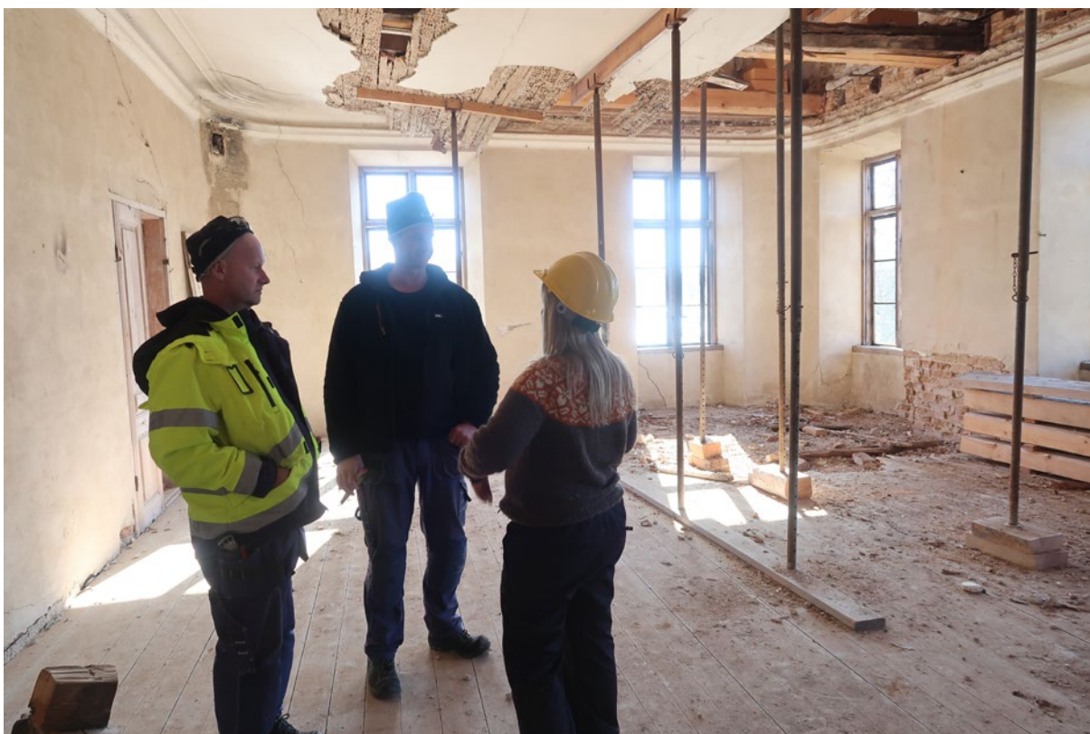
Rum 204. Fotografi mot väster. Det överliggande bjälklaget är provisoriskt stöttat. På bilden syns Johan Berglund, Rikard Möller och Liselotte Källström.
