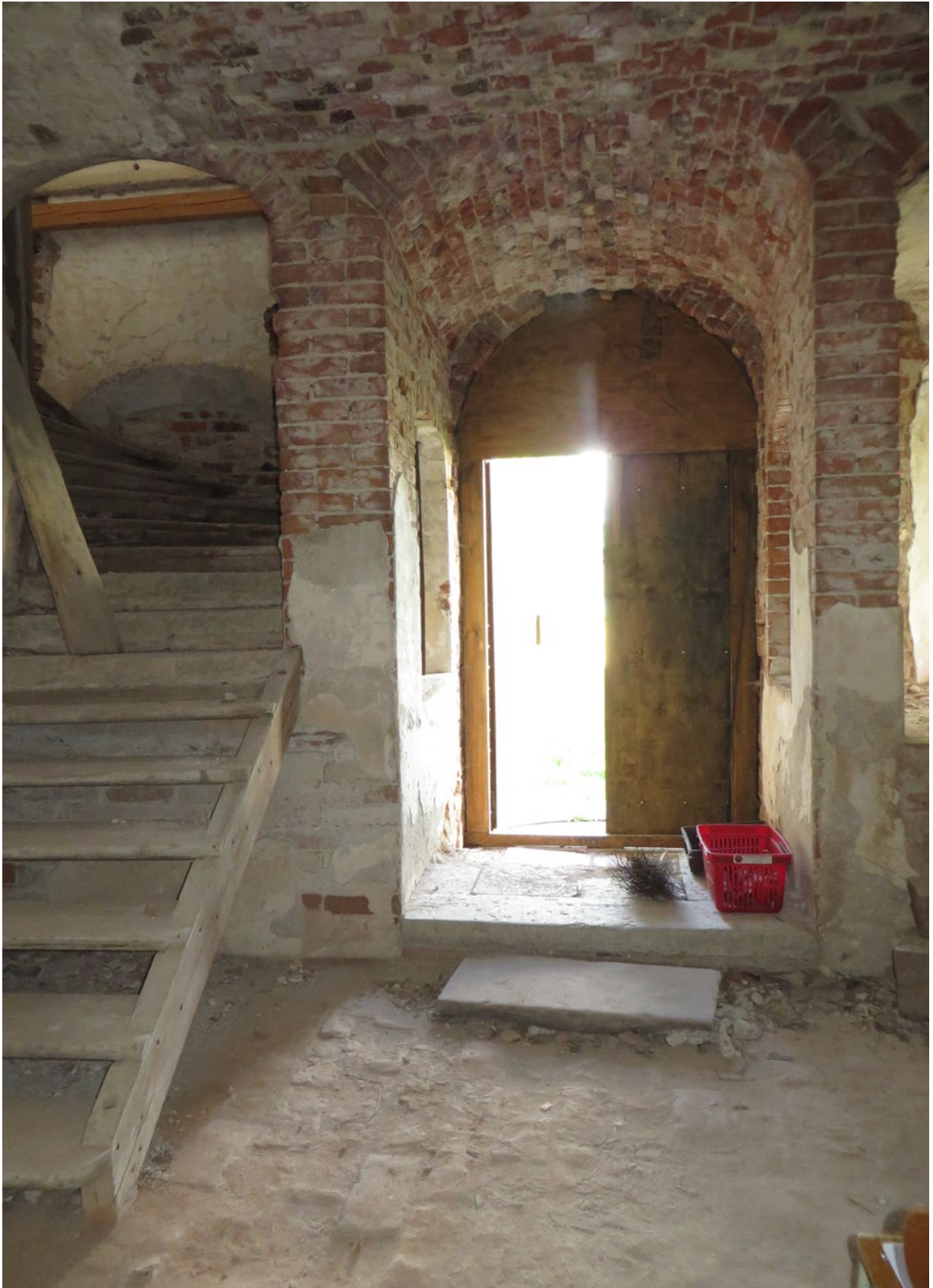
Rum 102 och 101 fotograferade från öppningen till rum 107. Till vänster syns trappan upp till övervåningen.
