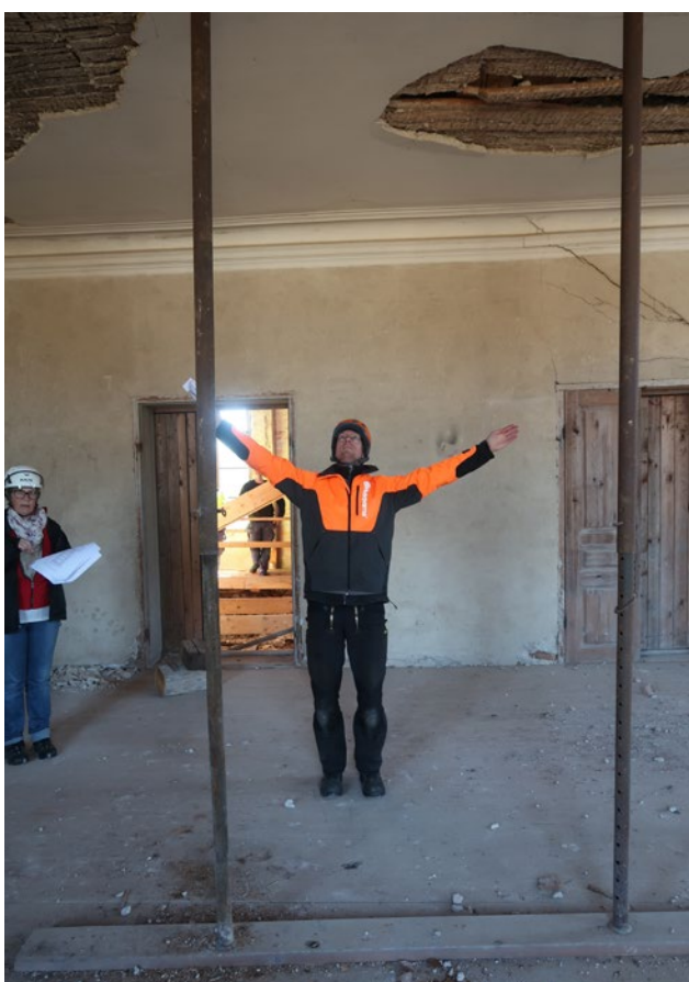
Rum 204. Fotografi mot väster. Det överliggande bjälklaget är provisoriskt stöttat. På bilden syns Johan Berglund, Rikard Möller och Liselotte Källström.
