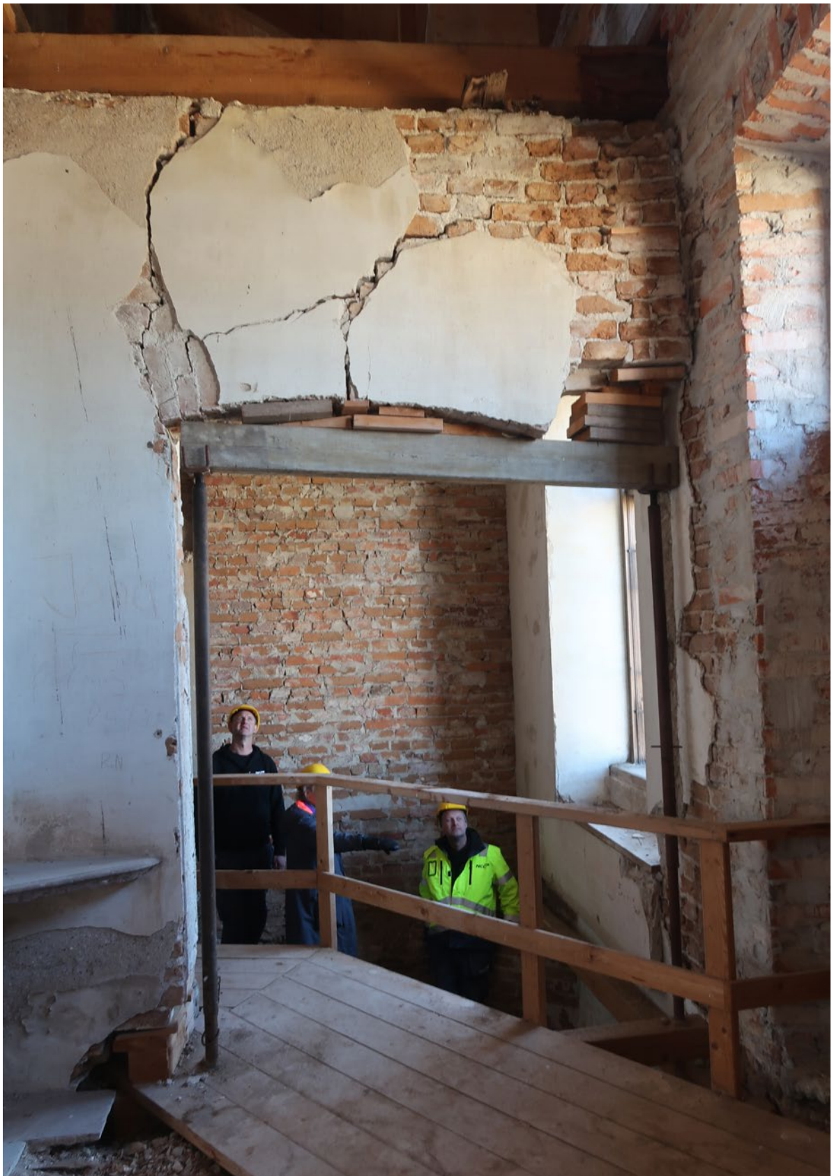
Fotografi från rum 201 mot rum 202. Den befintliga provisoriska stöttningen av det skadade valvet över öppningen är bristfällig.
