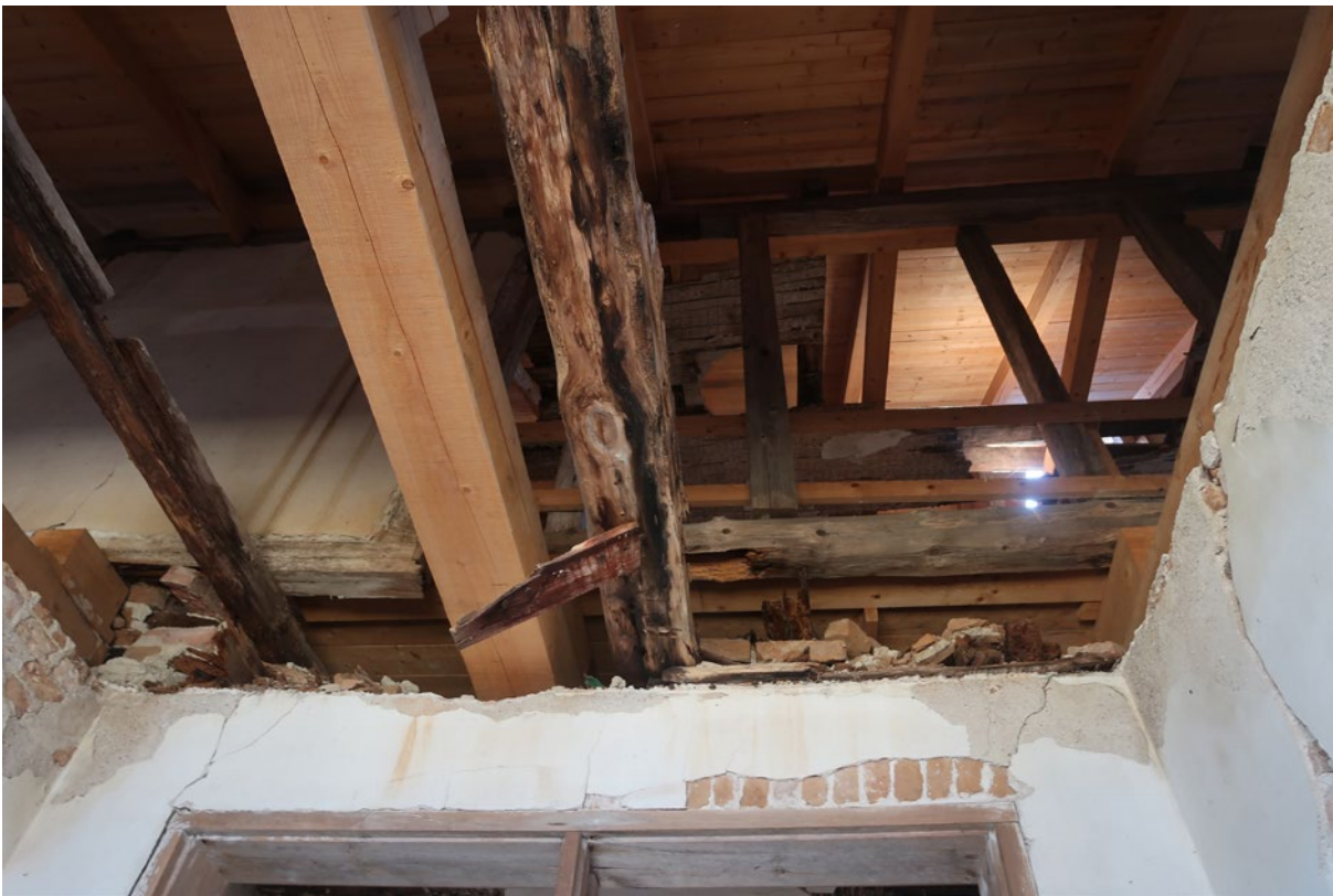
Rum 201. Fotografi mot innervägg i söder. Långstolen som syns under taket är dålig och behöver förstärkas.
