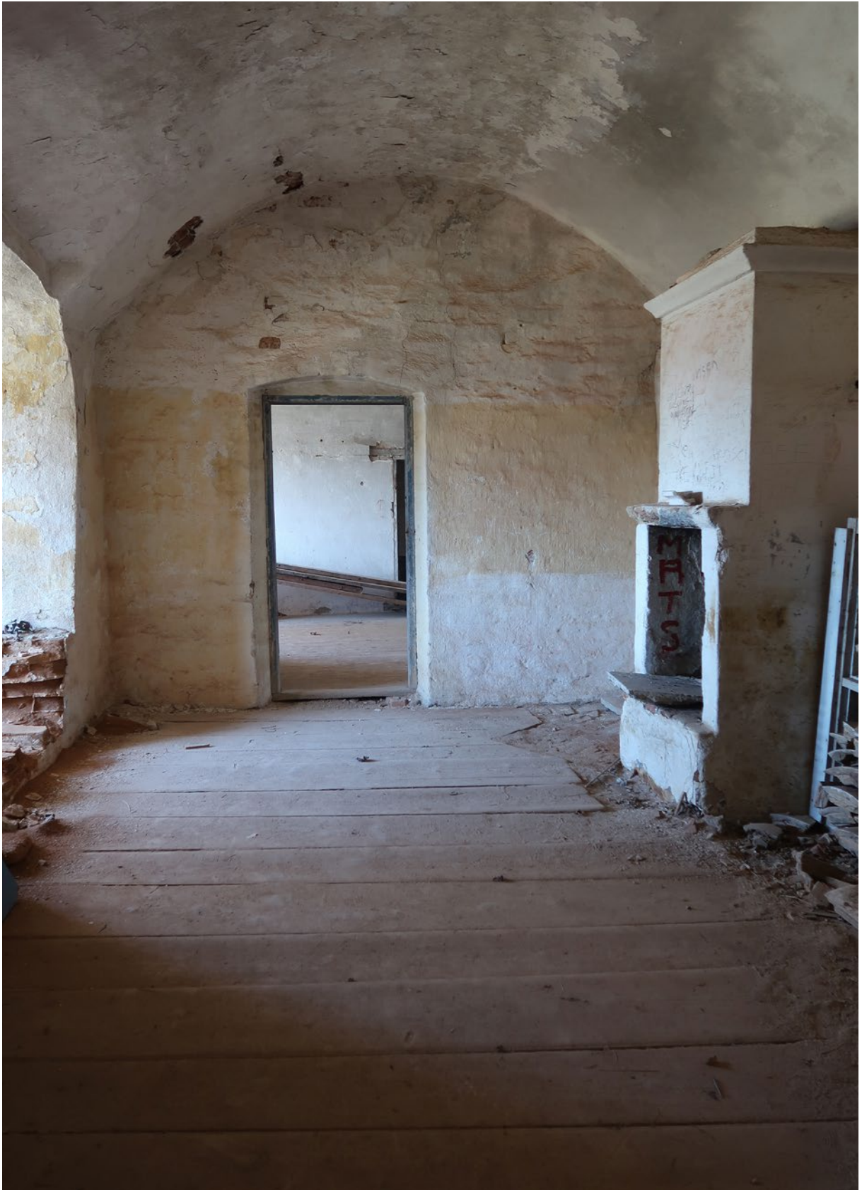
Rum 108. Rakt fram syns dörröppningen till rum 109.
