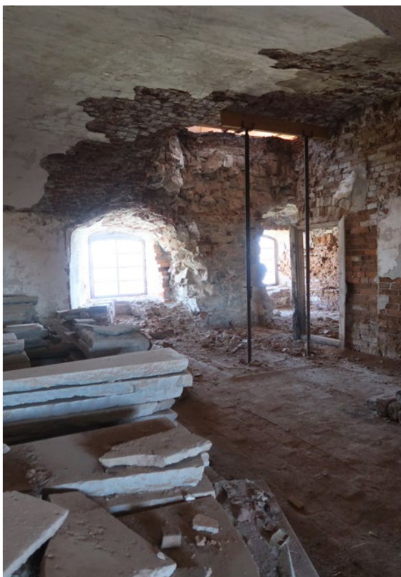
Rum 104 fotograferat mot sydväst. Rakt fram i bild syns hålet i bjälklaget mot rum 205.
