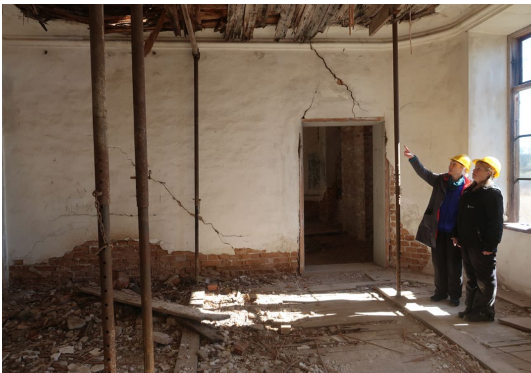
Funktionen hos många befintliga stöttor behöver ses över. På bilden syns Birgitta Eriksson och Liselotte Källström.
