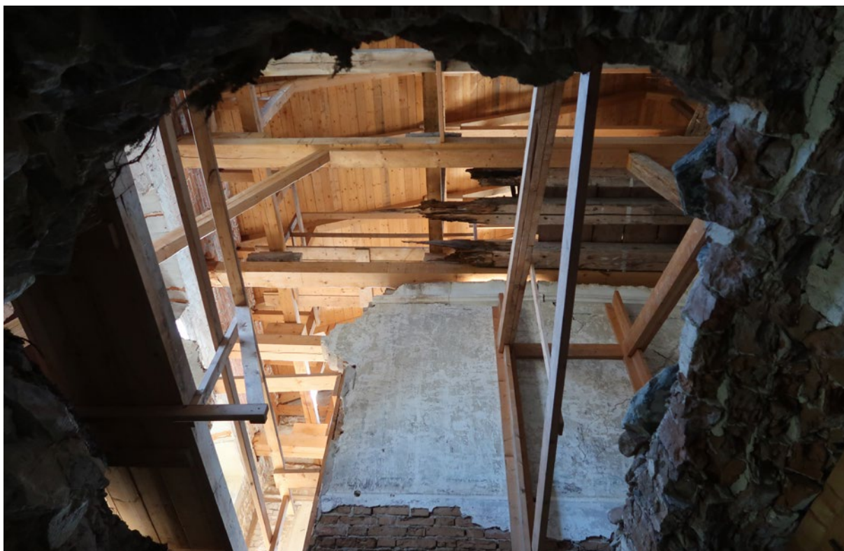
Fotografi genom hålet i bjälklaget över bottenvåningen, från rum 104 upp mot rum 205. Den putsade vita väggen är en mellanvägg mellan rum 205 och 206.
