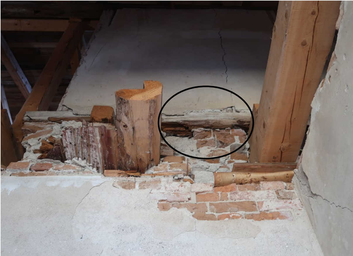
Rum 210. Fotografi mot innervägg i söder. Balken i underkant, inringad, av den långstol som bär taket är rötskadad.
