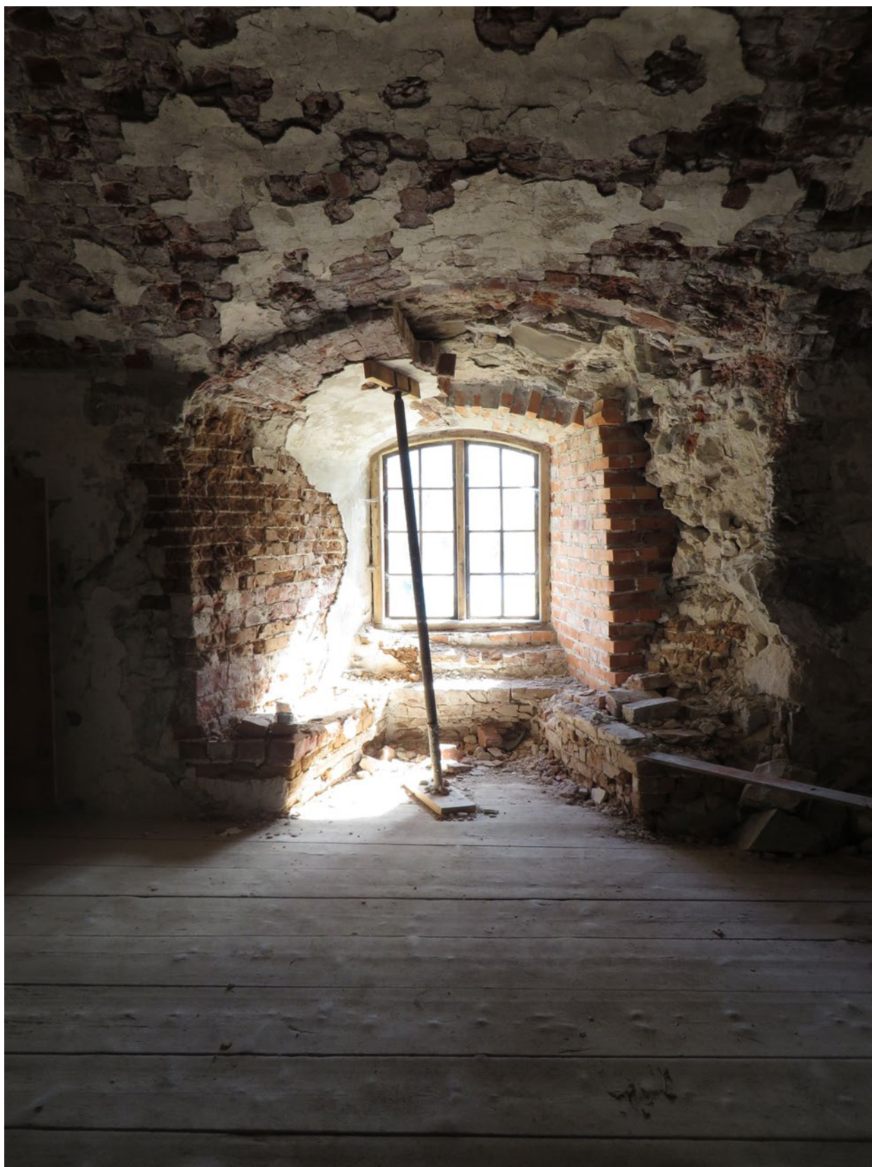
Provisoriskt utförd stämpling av skadat valv över fönsteröppning i rum 111.
