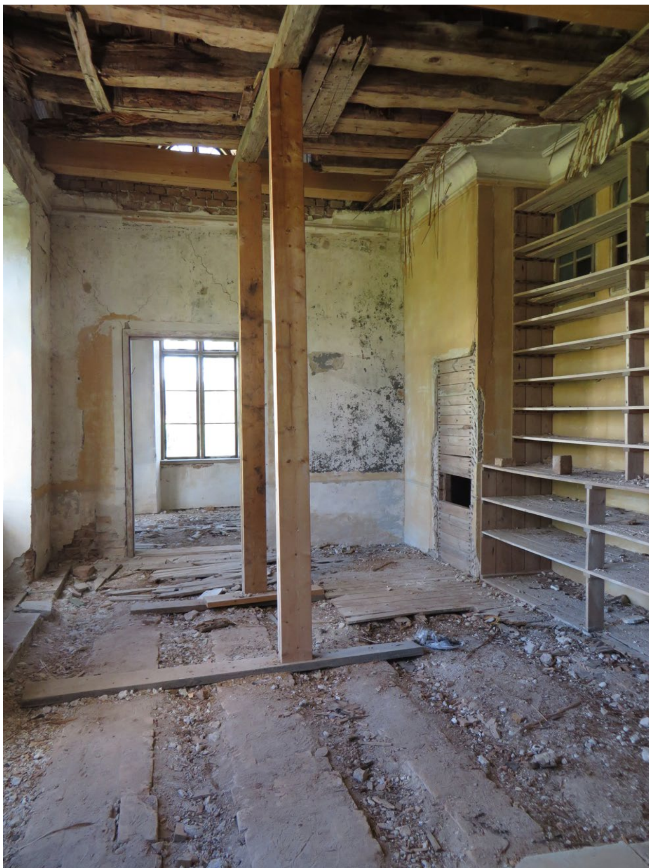
Rum 211. Fotografi mot öster. Genom dörröppningen rakt fram i bild syns rum 212.
