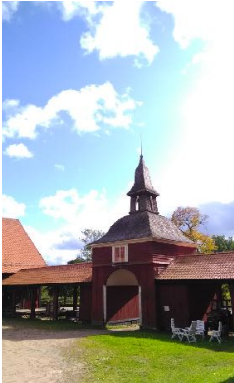
Tunarps torn innan arbetet startade sett från nordväst
