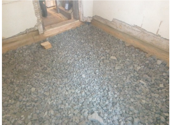
Här är syllarna på plats och vi fyller på med skumglas. Hasopor 10-60 mm är tillverkat av återvunnet glas och har värmekonduktivitet 0.102 W/mk och är kapillärbrytande mindre än 120mm i kappilär stighöjd.
