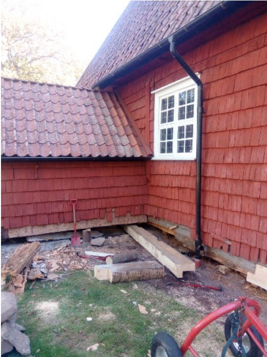
Här är den nya syllan mellan sakristia o långhus på väg in.
