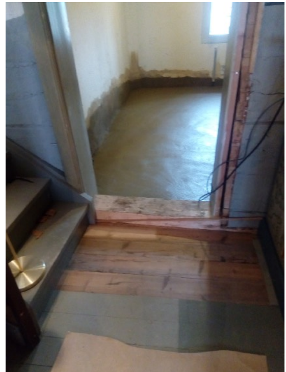
I det sista lerlagret lades golvärmeledningar. I dörröppningen tjänar den nya syllan som tröskel.
