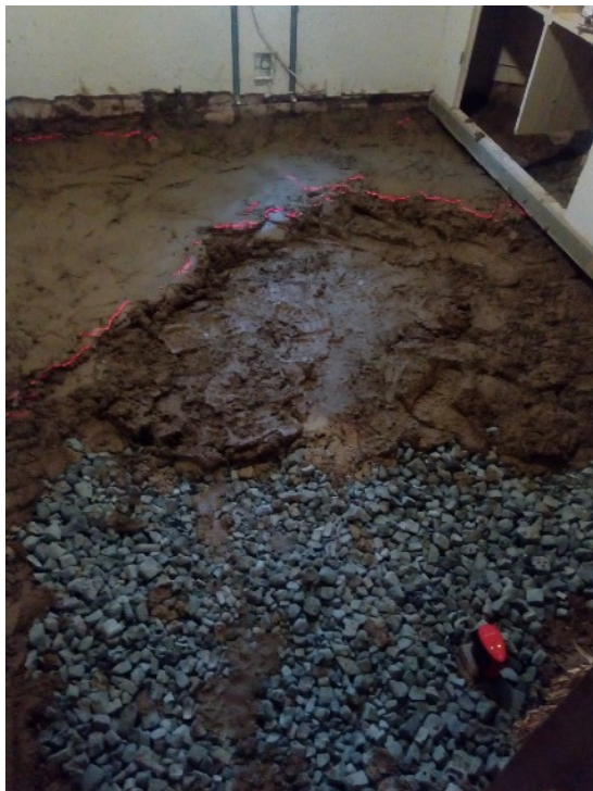
En textil markduk lades ut i sakristian, hasopor fylldes upp ca 35 cm, därefter en lerblandning av sand, lera och hampafibrer. Laser väger av golvet.
