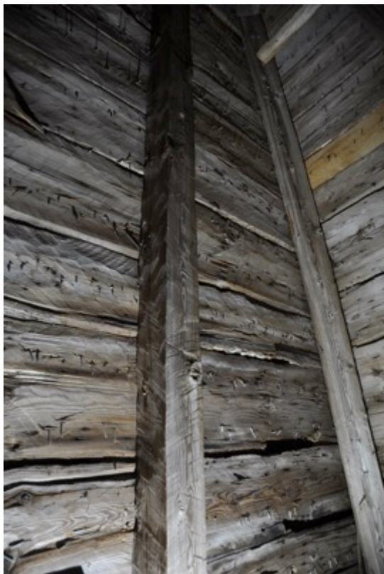
Bild från tornhuvens insida som visar sparrar och undertak, bearbetade med yxa i en medeltida behuggningsteknik kallad sprätthuggning.
