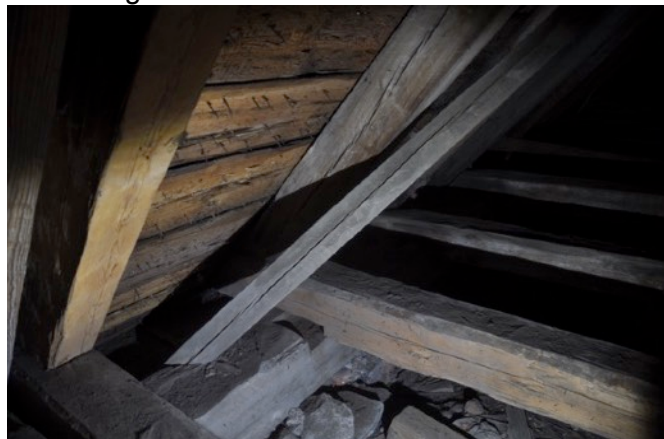
En ursprunglig längdförsträvning finns bevarad.
