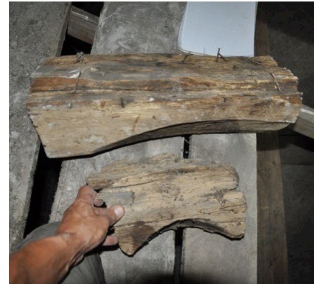
En jämförelse av nockåsar. Den övre från långhuset och den nedre från "västtornet". Båda mycket välarbetade och genomtänkta.
