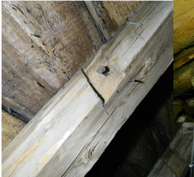
Sparren har dubbla urtag för stödben. Urtagen är ca 9 cm breda och stödbenen har varit fastspikade. Här sitter originalspiken kvar. Flera av urtagen är husade.
