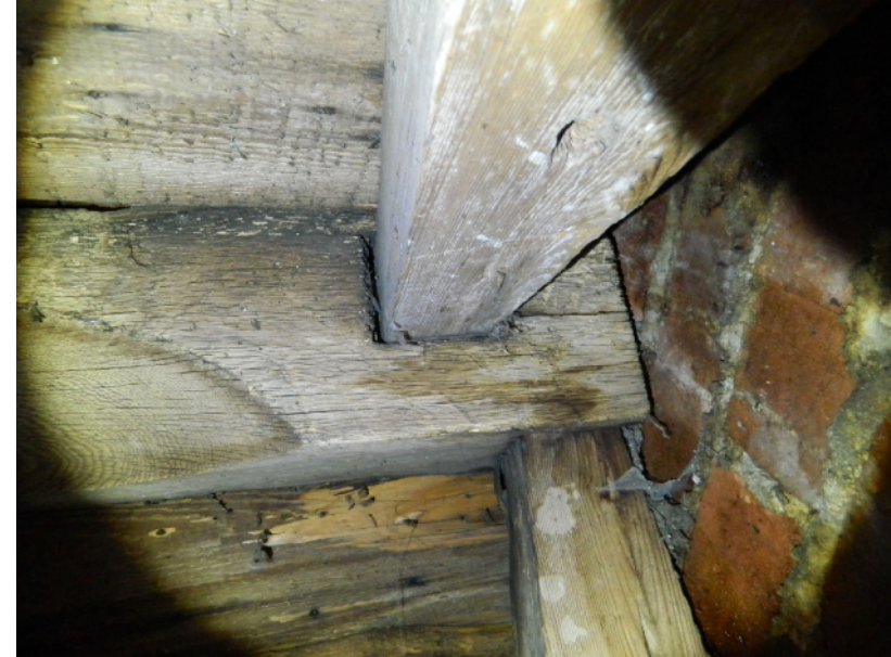
Sparrarna är inskjutna i nockåsen. Till höger syns skorstenen. Då den gjordes sågades en bit av nockåsen av, och finns sparad på vinden. Det gör att vi kan utläsa både hur nockåsen ser ut samt använda den till datering. Sparrarna är förskjutna, troligen för att inte försvaga nockåsen på samma ställe. I Härad sitter sparrarna på väster sida om bindbjälken och då är också tapparna i nocken förskjutna åt väster. I norr är det tvärtom.
