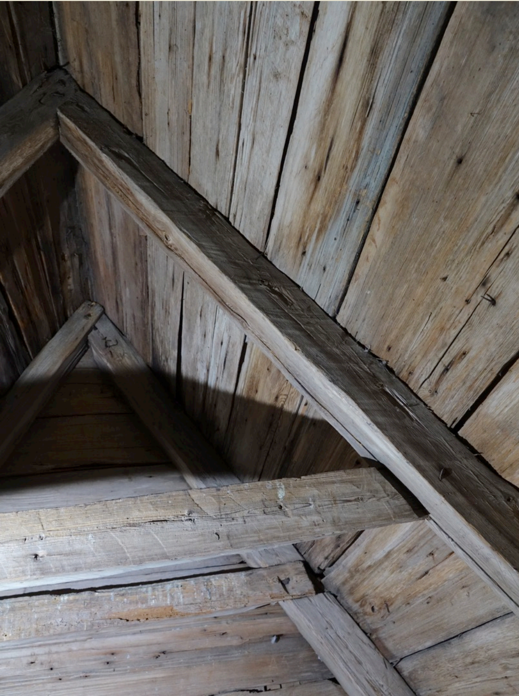
Stora delar av sadeltaket är tillverkat av kluvet virke som huggits med sprätthuggningsteknik, typiskt för medeltid före 1350, Digerdöden.
