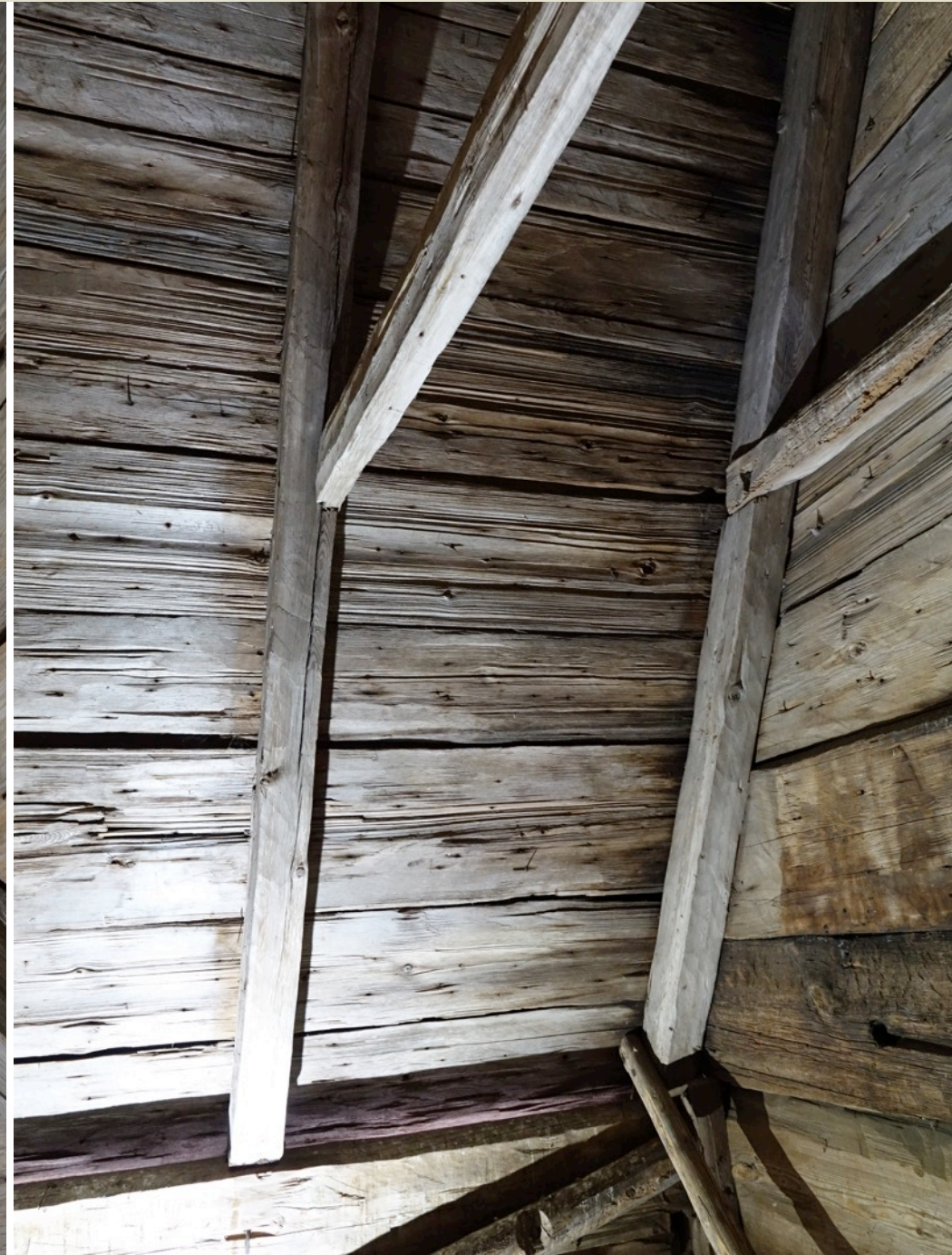
Stora delar av sadeltaket är tillverkat av kluvet virke som huggits med sprätthuggningsteknik, typiskt för medeltid före 1350, Digerdöden.
