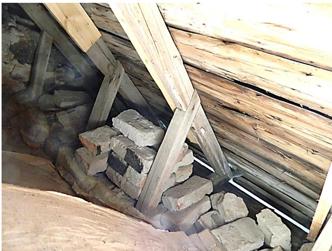
Vårdinge kyrkas sakristia har takstolar av gotisk typ och taktro av kluvna bräder. Bildnummer LP_2015_00088. Foto Bengt Bygdén
