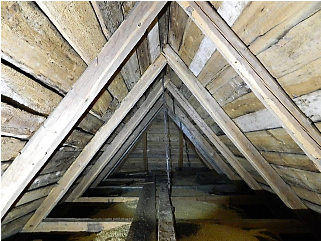
Mörkö kyrkas taklag är sannolikt från 1700-talet. Bildnummer LP_2015_00084. Foto Bengt Bygdén
