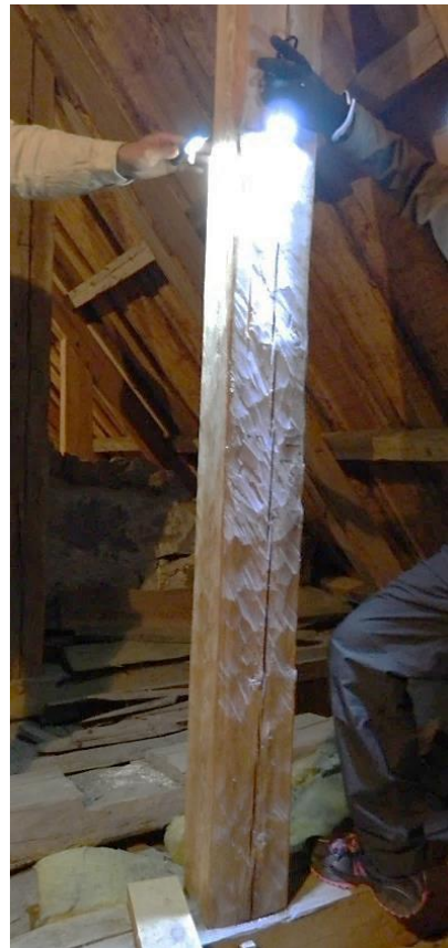
Bilden till höger visar återanvänd medeltida bjälke, med sprätthuggen yta. Bildnummer LP_2015_00099. Foto Bengt Bygdén
