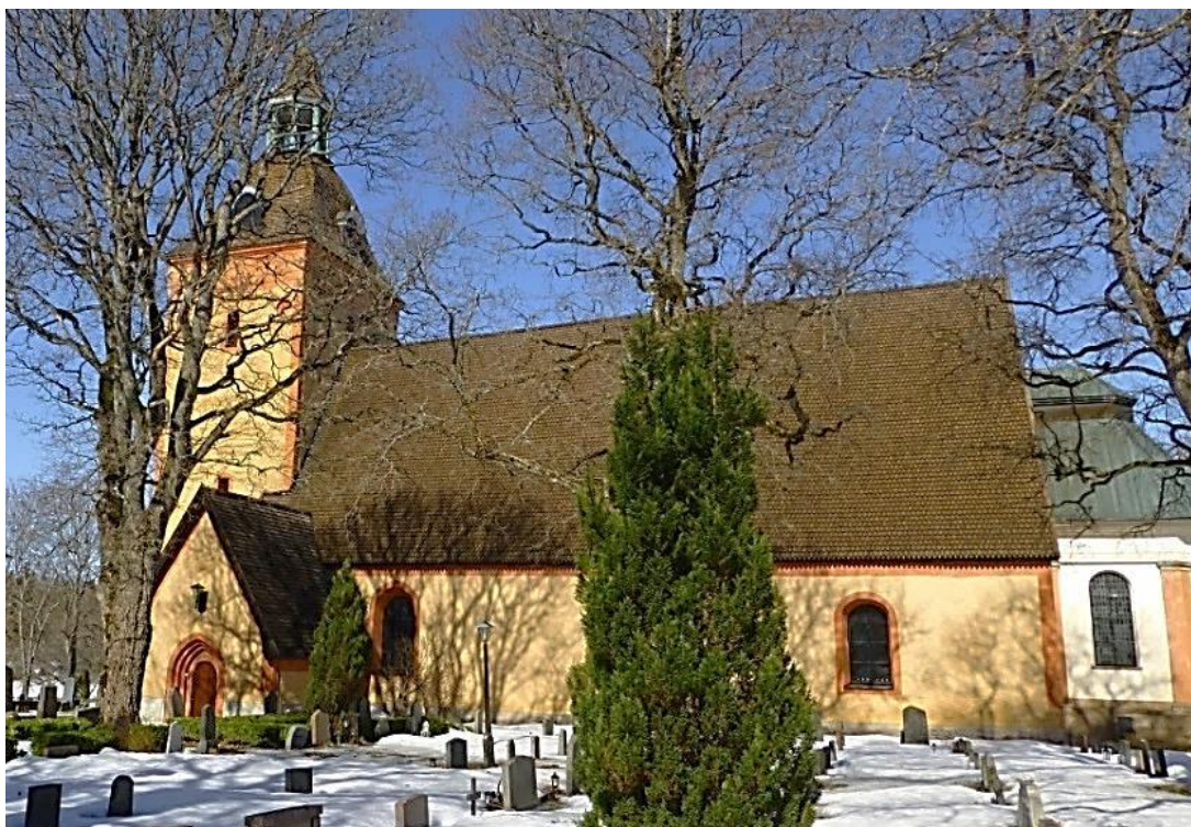
Ösmo kyrkas södra sida 2013-04-03. Senaste fasadrenoveringen skedde 1994. Bildnummer LP_2015_00071. Foto Bengt Bygdén
