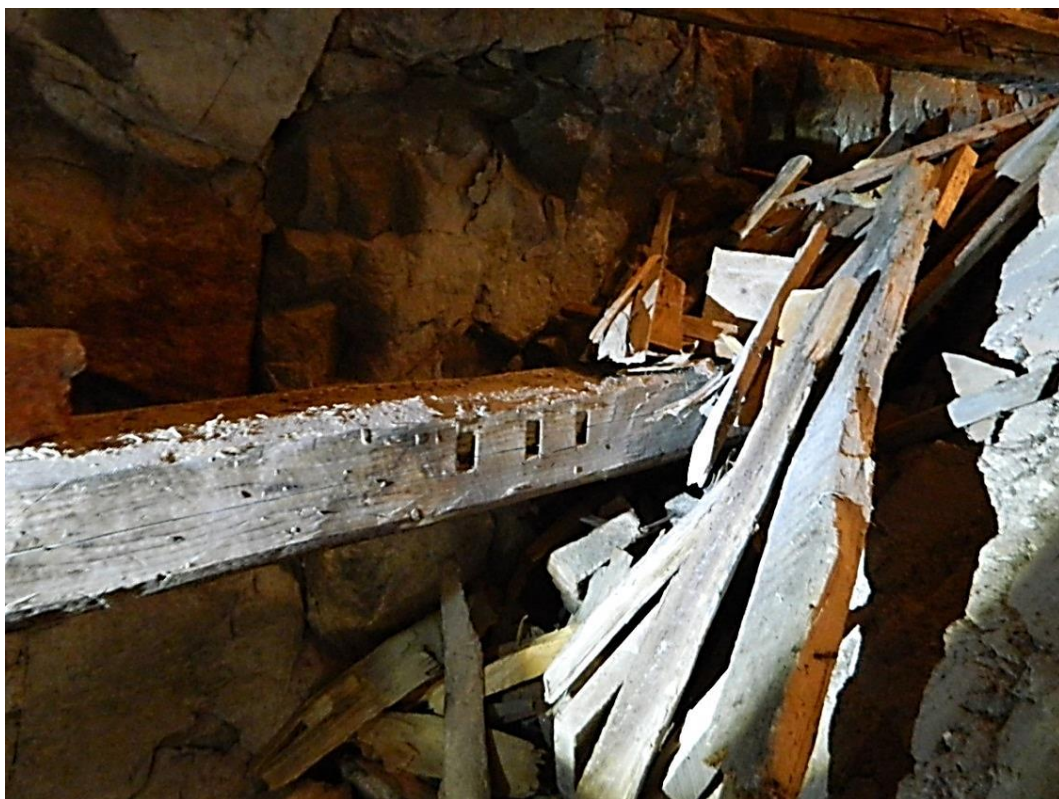
På Överenhörna kyrkvind finns en återanvänd, sannolikt senmedeltida saxsparre med timmermansmärkning. Bildnummer LP_2015_00092. Foto Bengt Bygdén
