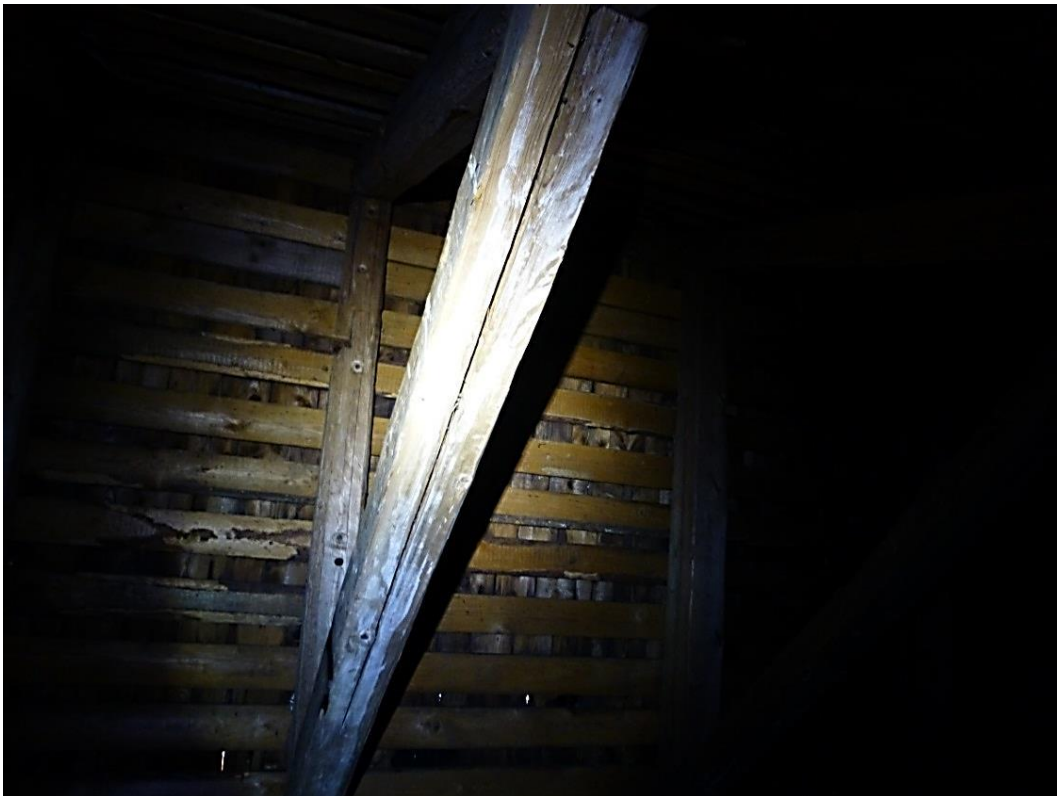
På Salems kyrkvind, över långhusets äldre del, finns rester av vit färg på banbjälke. Bildnummer LP_2015_00076. Foto Bengt Bygdén
