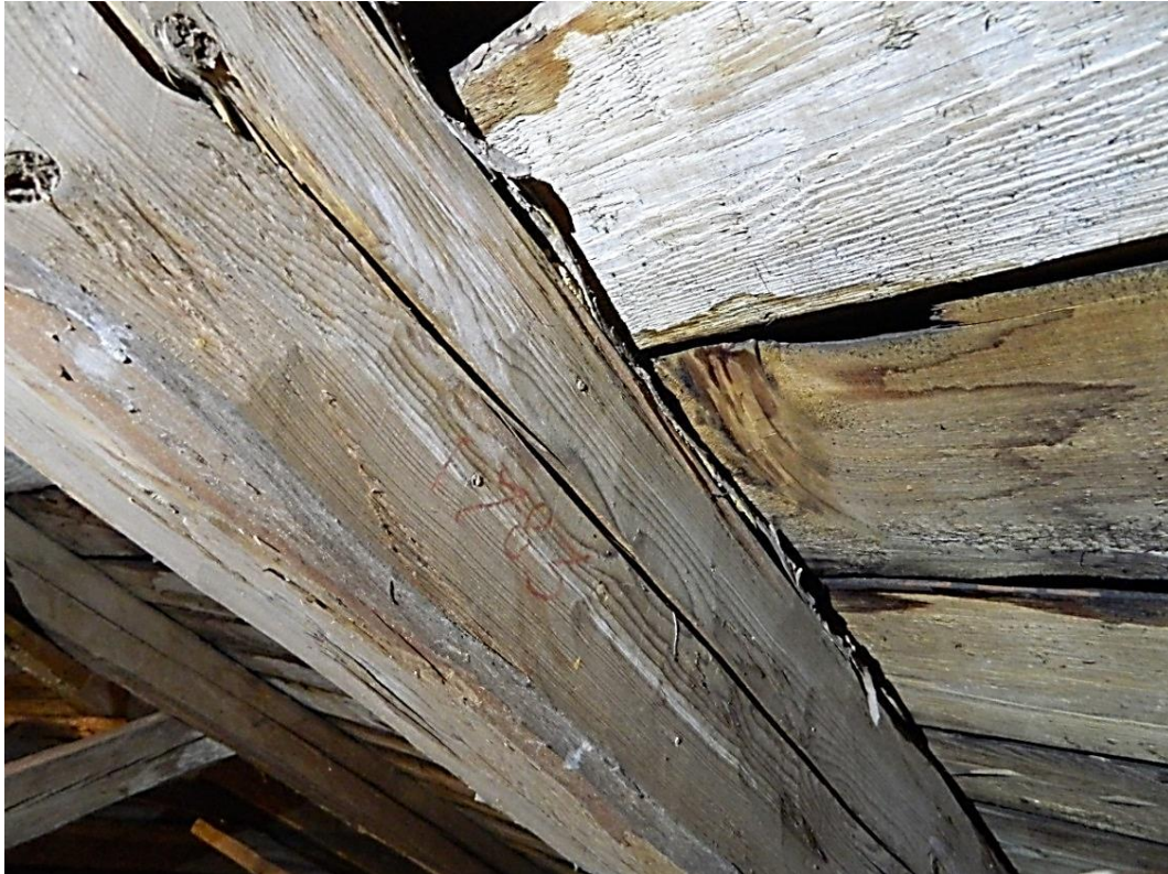
På kyrkvinden i Överenhörna kyrka har en av taklagets saxsparrar daterats. Årtalet 1783 finns utskrivet med rödpenna. Bildnummer LP_2015_00093. Foto Bengt Bygdén
