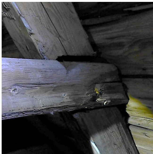
I Grödinge kyrka är taklagens knutpunkter utförda halvt i halvt med hak. Foto Bengt Bygdén.
