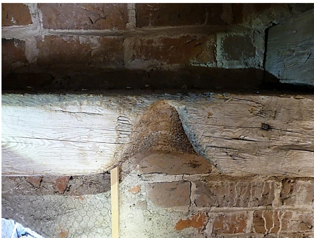
I Grödinge kyrktorn finns en bjälke som slitits av många hundra års klockringning. Bildnummer LP_2015_00063. Foto Bengt Bygdén
