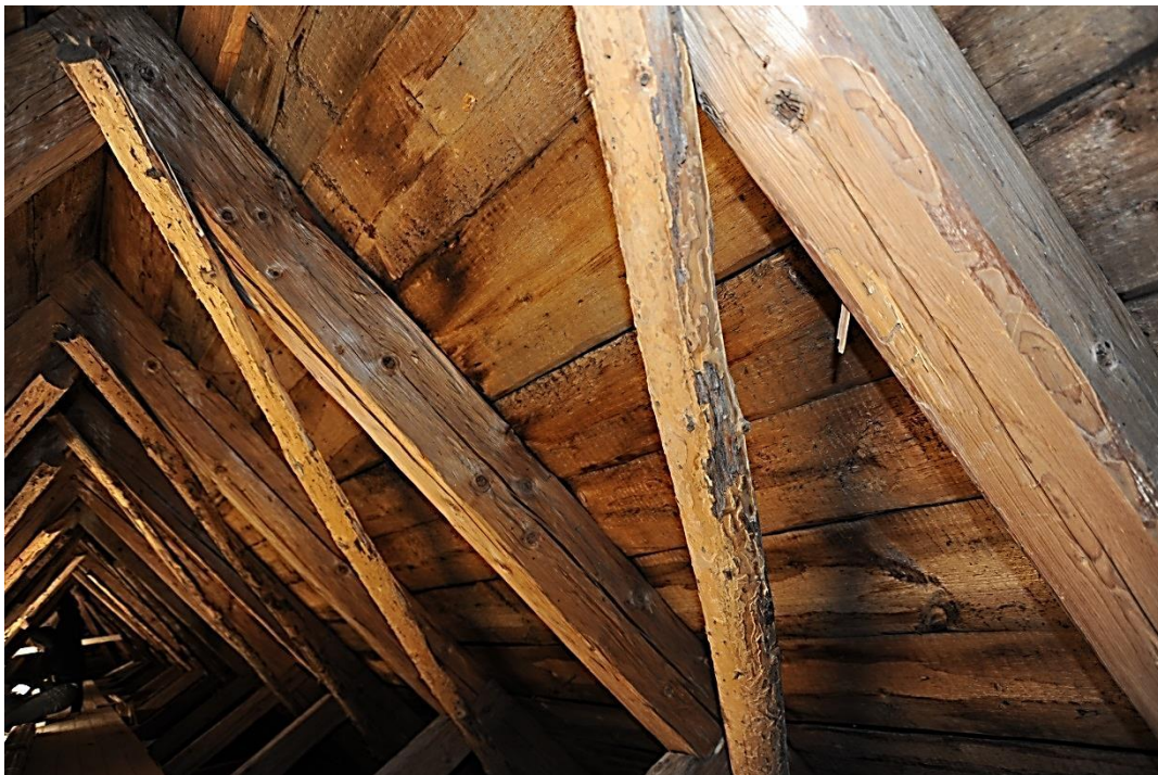
Taklaget närmast nocken på kyrkvinden i Överenhörna. Foto Rolf Hammarskiöld.
