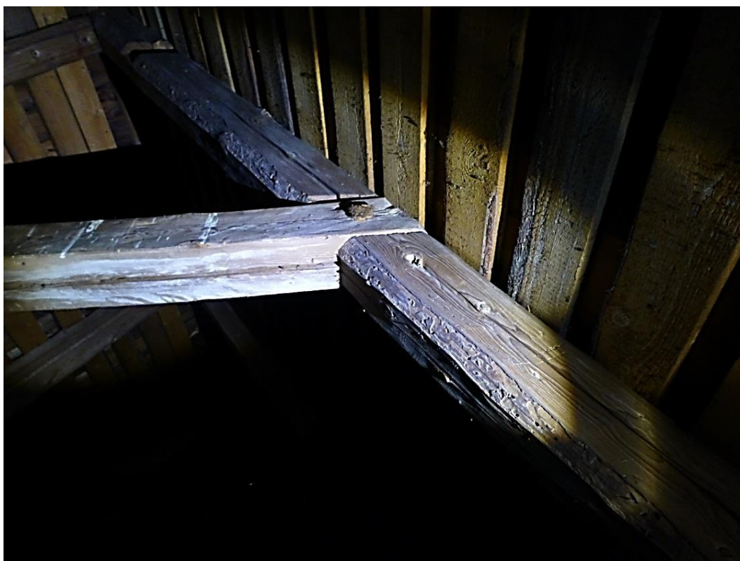
Ovanstående bild från Salems kyrkvind visar en dymlad knutpunkt och ett högben som har vankant med granbark. Bildnummer LP_2015_00078. Foto Bengt Bygdén
