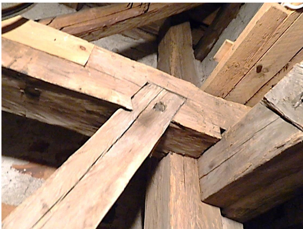
I Ytterjärna kyrktorns bärverk dokumenterades busad knutpunkt halvt i halvt med hak. Bildnummer LP_2015_00095. Foto Bengt Bygdén 2013-06-25
