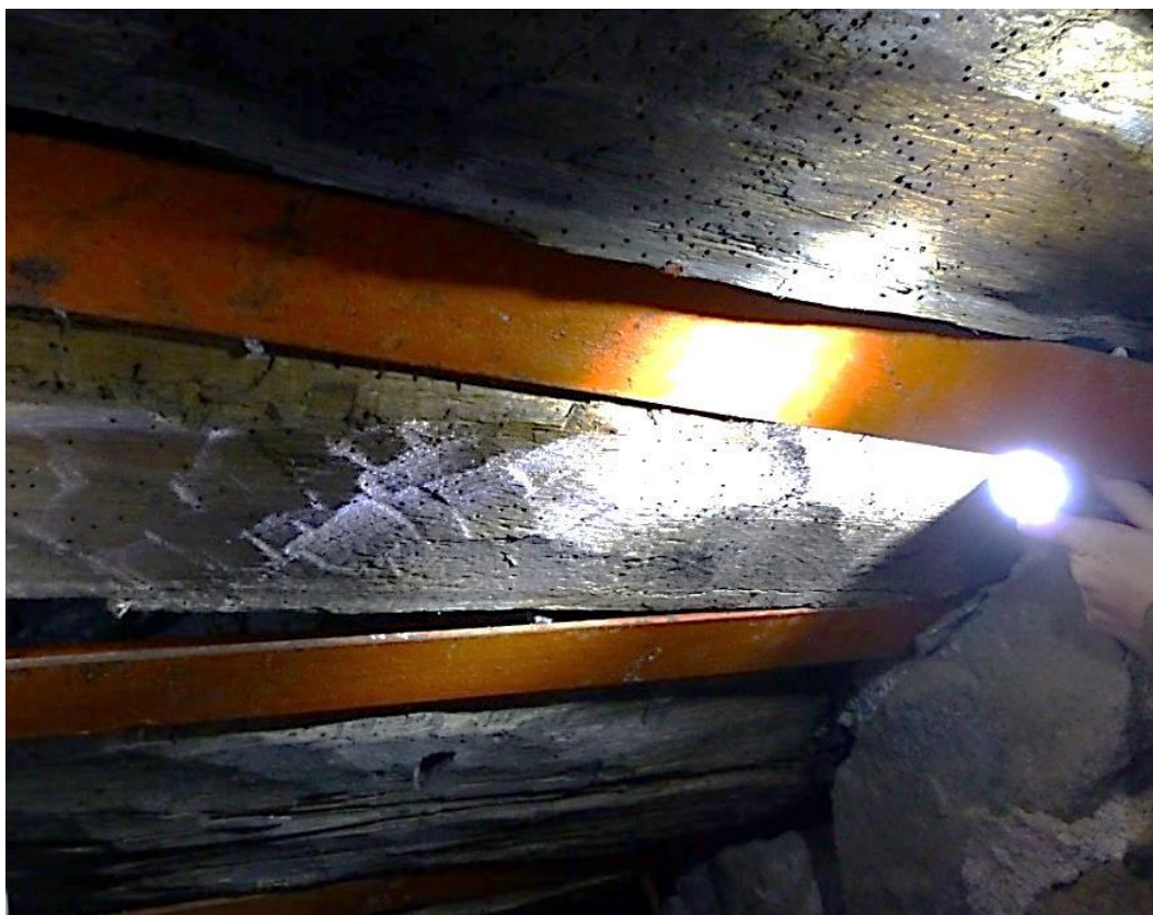
I passagen mellan Salems kyrktorn och långhusets vind sitter tydligt sprutthuggna ekplankor i taket. Sprutthuggningen indikerar att tornet byggdes före digerdöden. Bildnummer LP_2015_00077. Foto Bengt Bygdén
