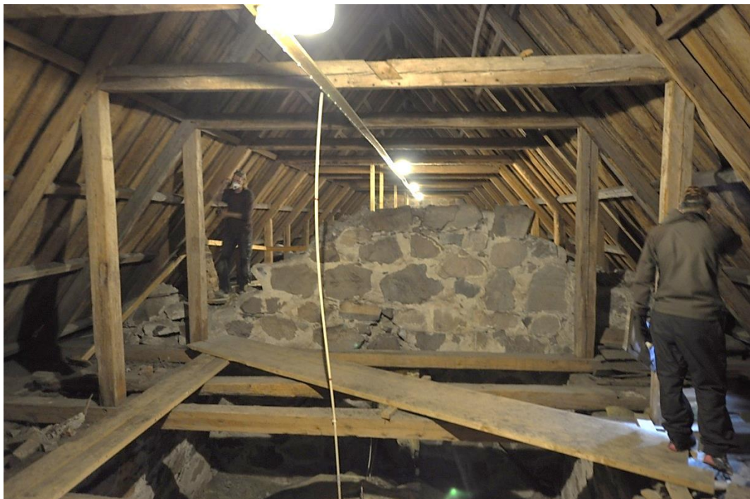
Ovan ses en översiktsbild av Överjärna kyrkvind, med långhusets östra gavelmur. Avtryck av äldre sadeltakfall syns i murens mitt. Bildnummer LP_2015_00100. Foto Albin Uller
