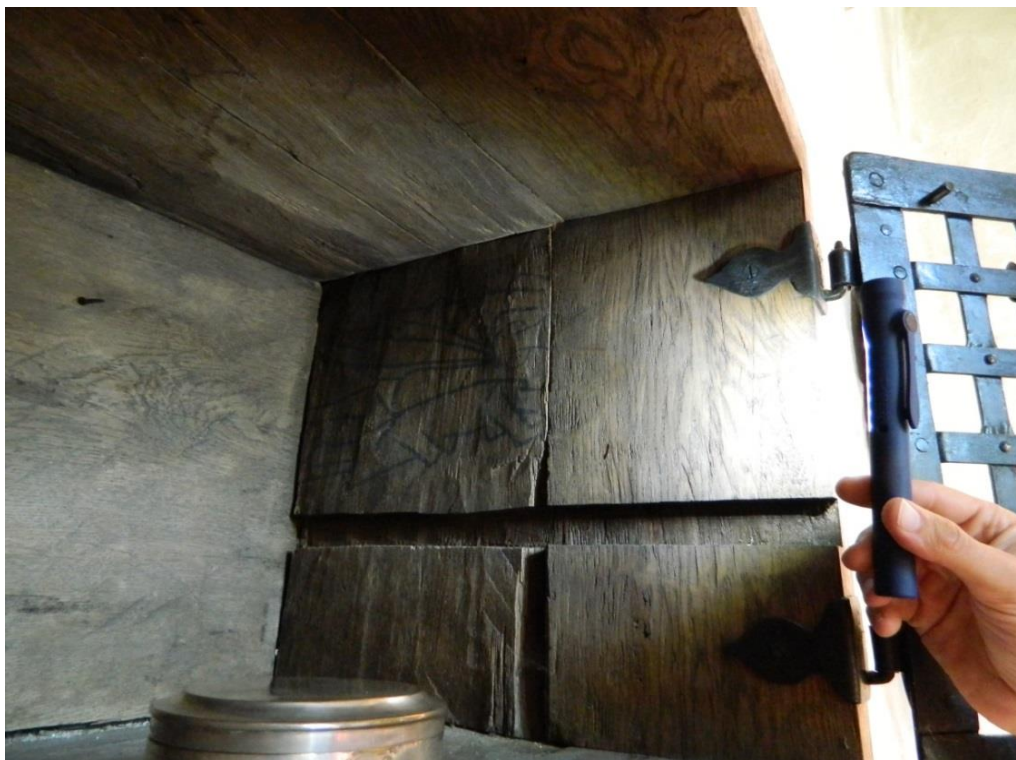
I Överjärna kyrkas kor finns en nisch fodrad med delvis sprätthuggen medeltida ek. Bildnummer LP_2015_00096. Foto Bengt Bygdén
