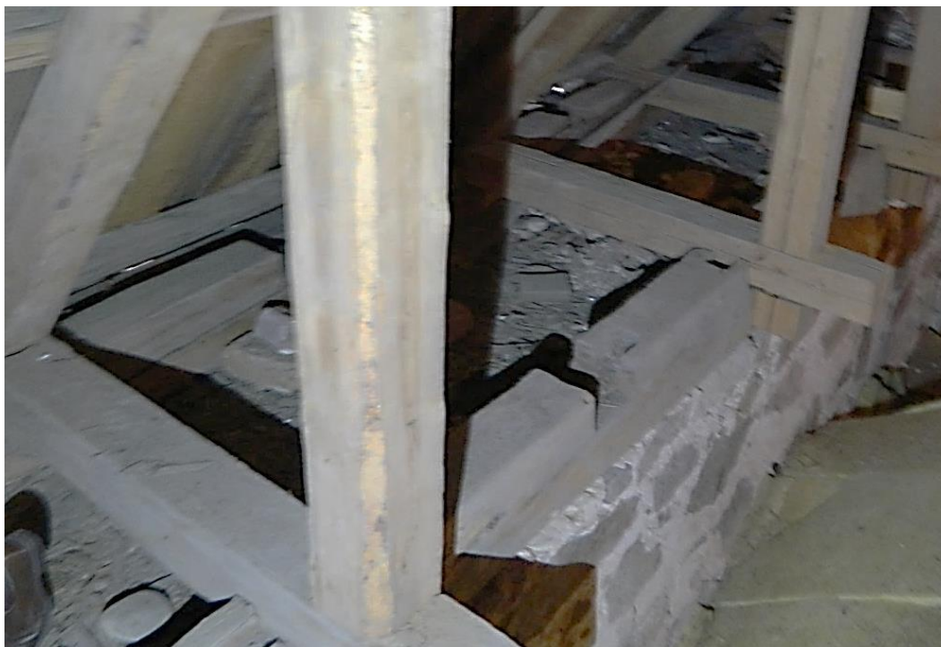
Närbild av remstycken och stödben på Överjärna kyrkvind. Foto Bengt Bygdén
