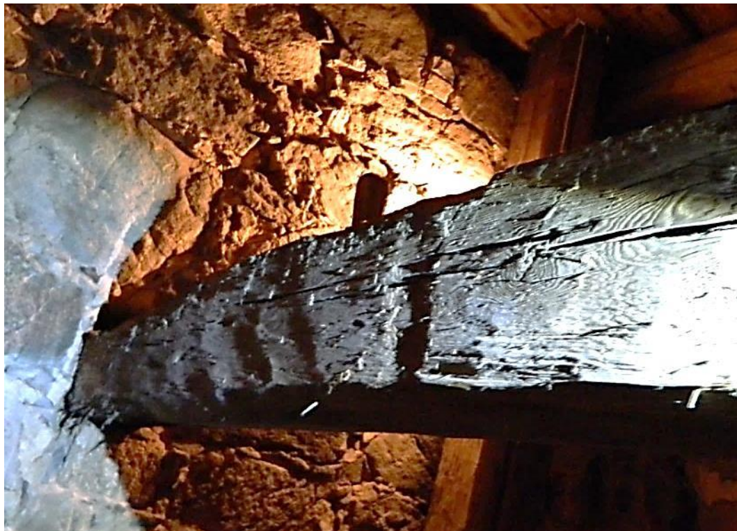
Tveta kyrktorns bärverk sticker in i muren. Bildnummer LP_2015_00086. Foto Bengt Bygdén
