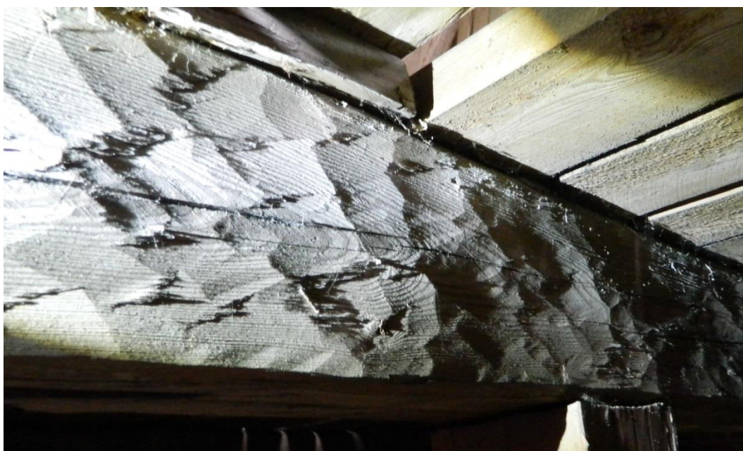
I Hölö kyrktorn förekommer äldre konstruktionsvirke. Foto Bengt Bygdén.
