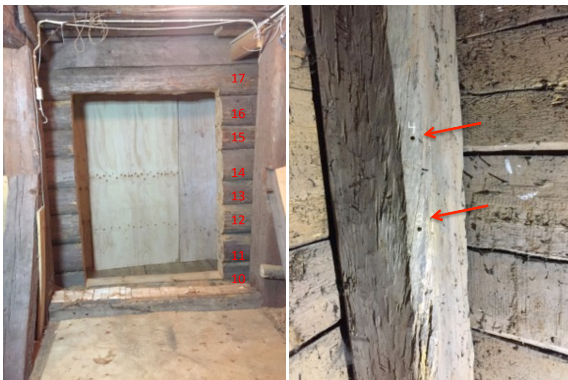
Till vänster syns den nygjorda öppningen mellan orgelläktaren och tornets första våning. Timmervarven är numrerade från 1-17, där 1 är syllstocken och 17 är väggbandet (timmerstommens översta stock). Till höger, tornets nordvästra hörnstolpe med borrhål tre och fyra.
