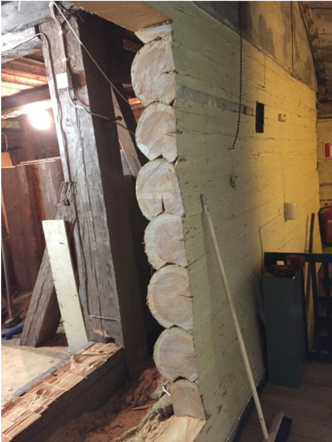
I den nyupptagna öppningen mellan orgelläktaren ser man att endast insidan är slätbilad. Notera den stora andelen kärnved som syns i stockarnas ändträ.
