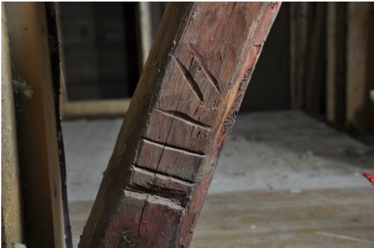
Exempel på timmermansmärkning i tornet.
