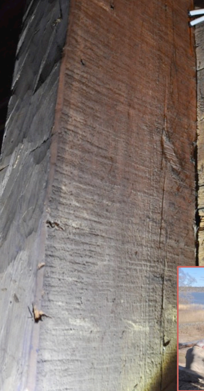
Spår av vattendriven ramsåg, troligen enkelbladig. 1600-tal.
