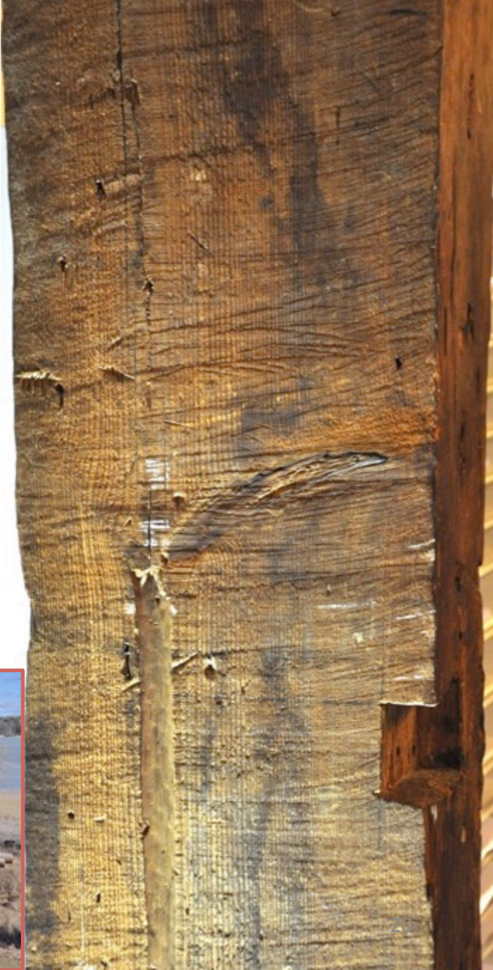
Kransågade stockar, sågade med handkraft på sågbock. 1600-tal.
