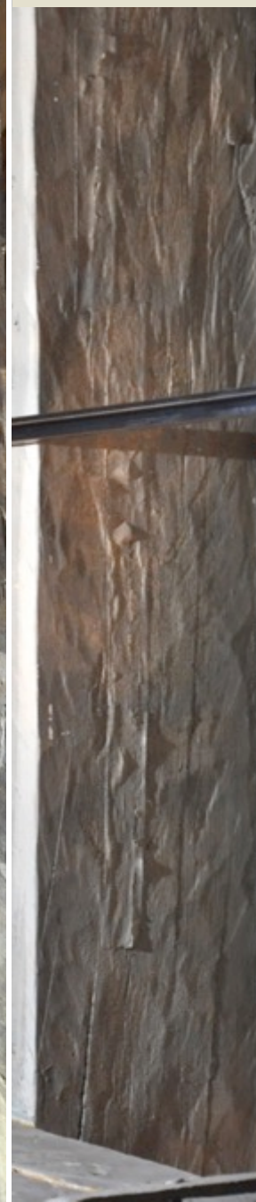
1900-talsbehuggning i bottenvåningen. Olika timmermän med olika yxor, då som nu.
