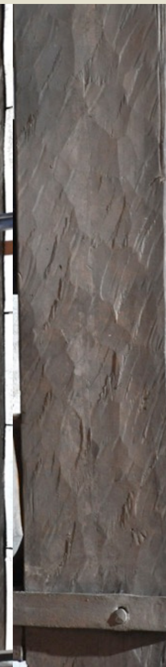
1900-talsbehuggning i bottenvåningen. Olika timmermän med olika yxor, då som nu.
