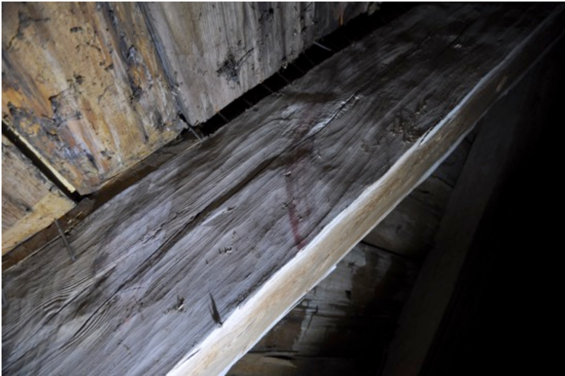
I släpljuset framträder spåren efter skaven, vars rundade stål gett längsgående färör i veden. Man ser också tydliga rester av måleri.
