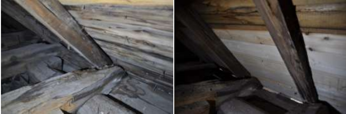
Bilderna visar undertaket före och efter omläggning. Numer finns inga ursprungliga brädor bevarade.
