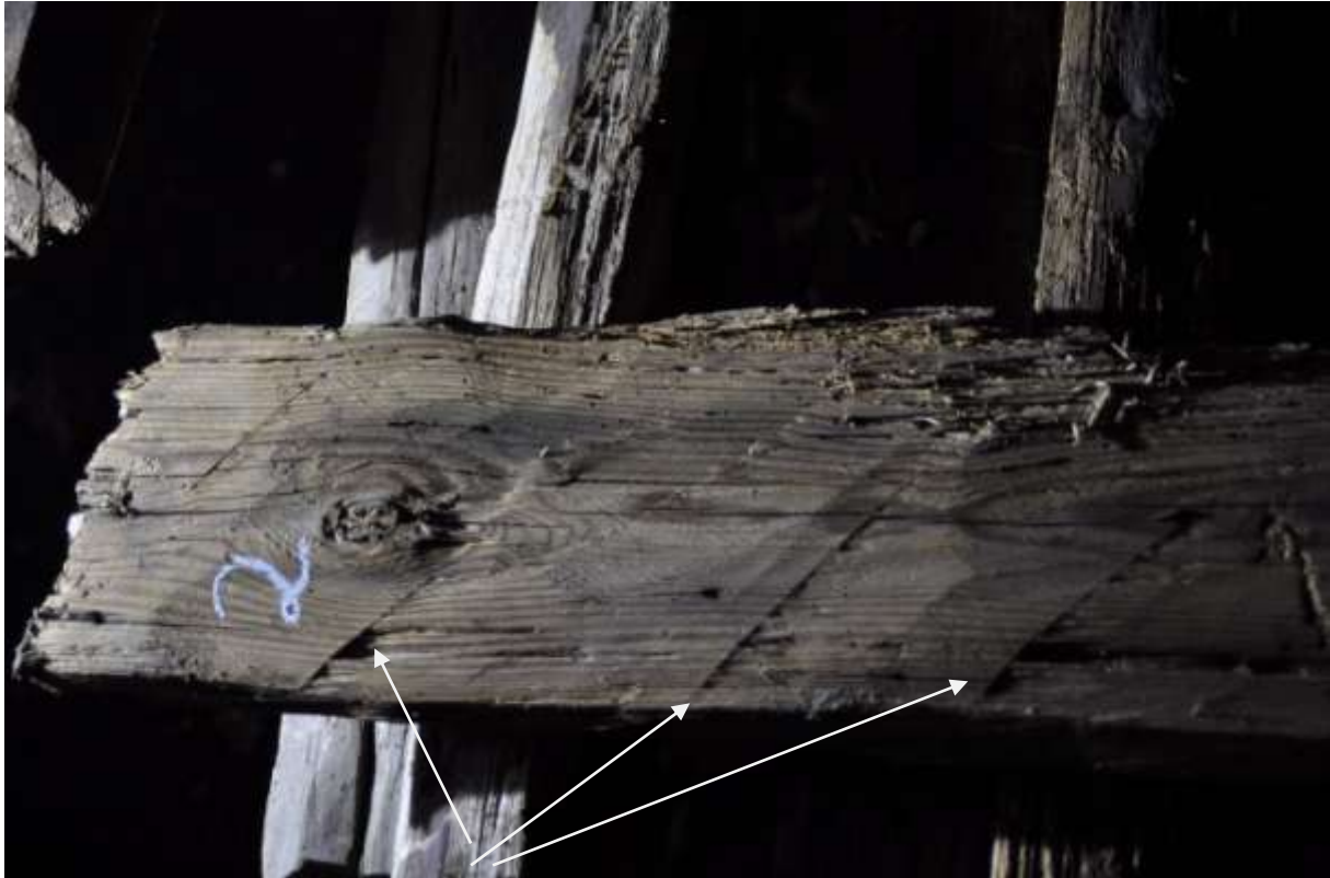
Många bitar har diagonala upplättningshugg. Detta görs, om man vid finhuggningen har ganska mycket ved kvar att hugga bort, för att underlätta avverkningen.
