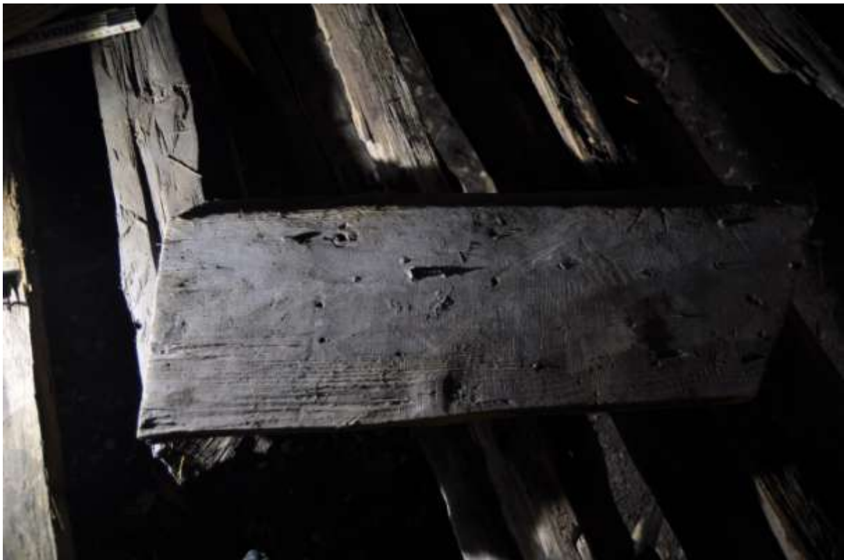
Observera de vibrationsspår som uppstått när ytan bearbetats med skave, en form av hyvel. Att virket bearbetades på detta vis var mycket vanligt under medeltiden.
