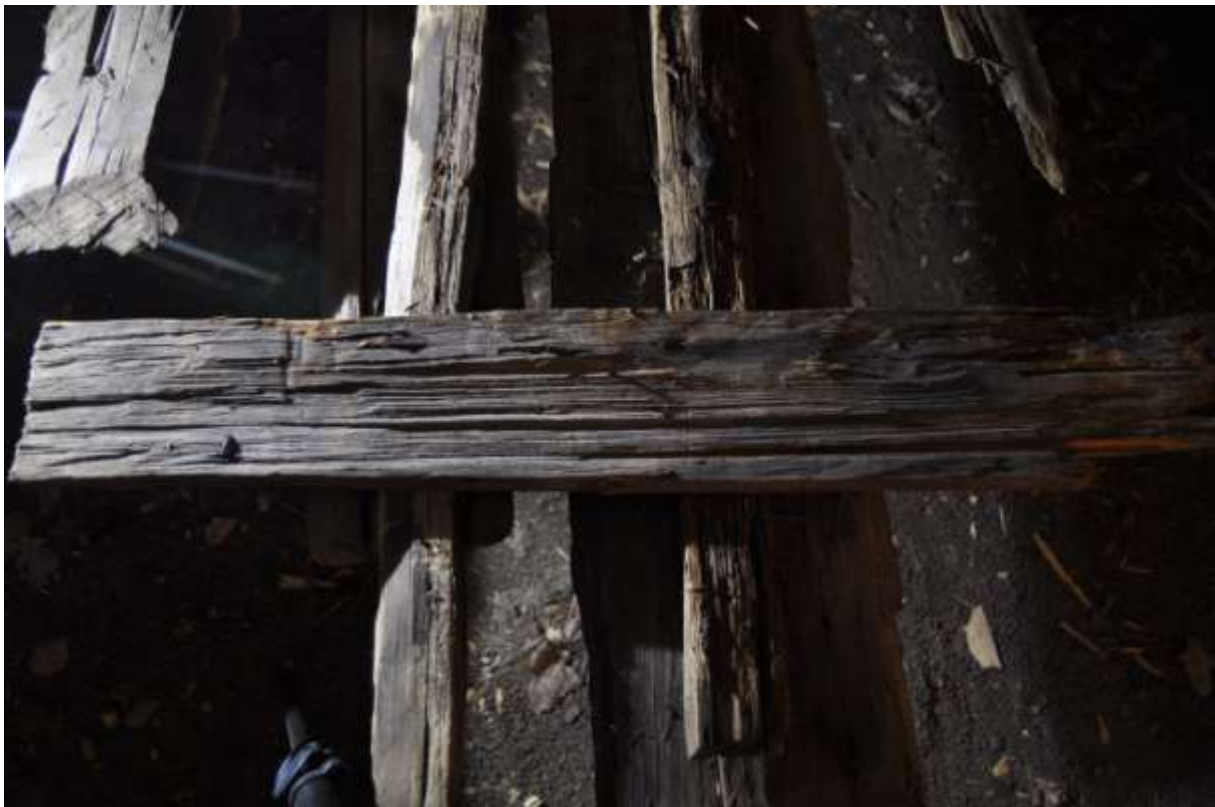
Denna bräda har framställts genom klyvning. Virket är mycket rakvuxet och den klyvda ytan har knappats bearbetats ytterligare.
