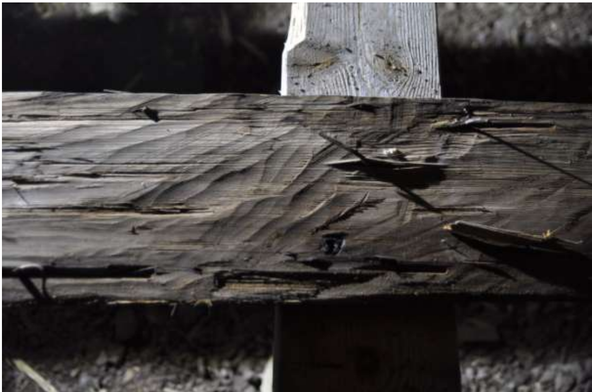
Här har en skave använts diagonalt och tvärs fibrerna, kanske för att justera en ojämnhet vid monteringen av brädan. Notera reporna från en skada i eggen.
