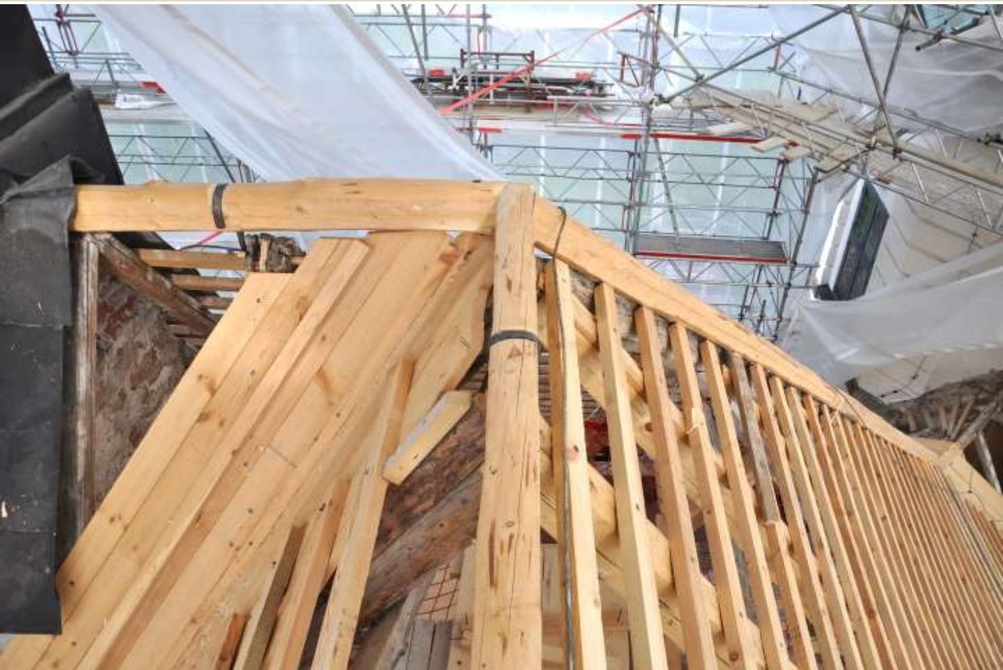
Stilstudie pånockarnas möten med gradsparren och övre delen av den nya vinkelrännan ner mot borggården. Inte helt färdig vid fototillfället.
