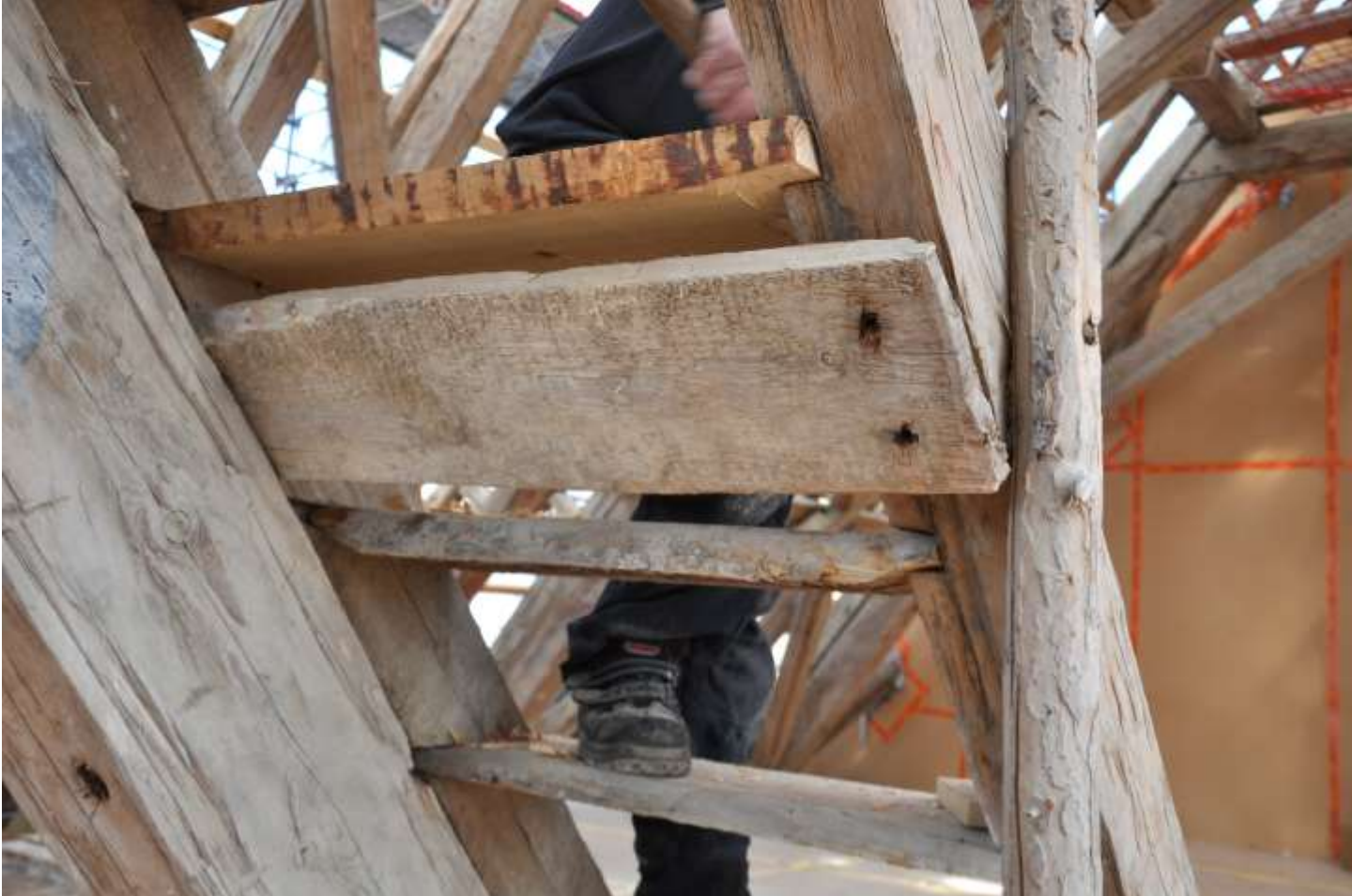
Vi blev tvungna att demontera alla stegen för att med spännband kunna dra ihop sidostyckena för bättre passform på bredden.
