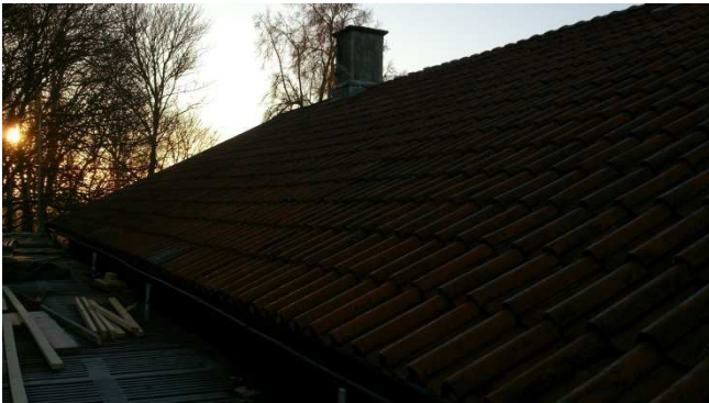
Färdigt tak med östra skorstenen.
