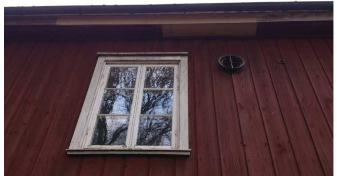
Lagning i takfot vid skada 1.
