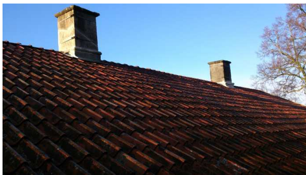
Färdigt tak med båda skorstenarna.
