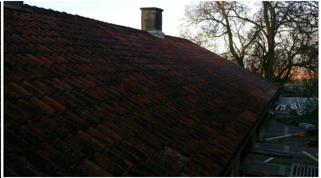
Färdigt tak med västra skorstenen.
