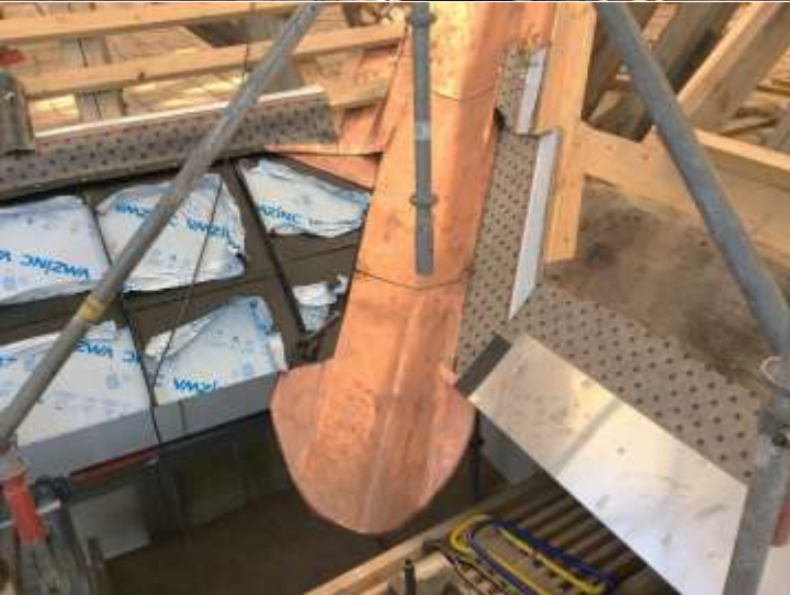
Vikens plåt och deras arbeten med vinkelrännan, takluckan och takfotsplåten. Fredrik var ansvarig plåtslagare på plats. En duktig sådan.
