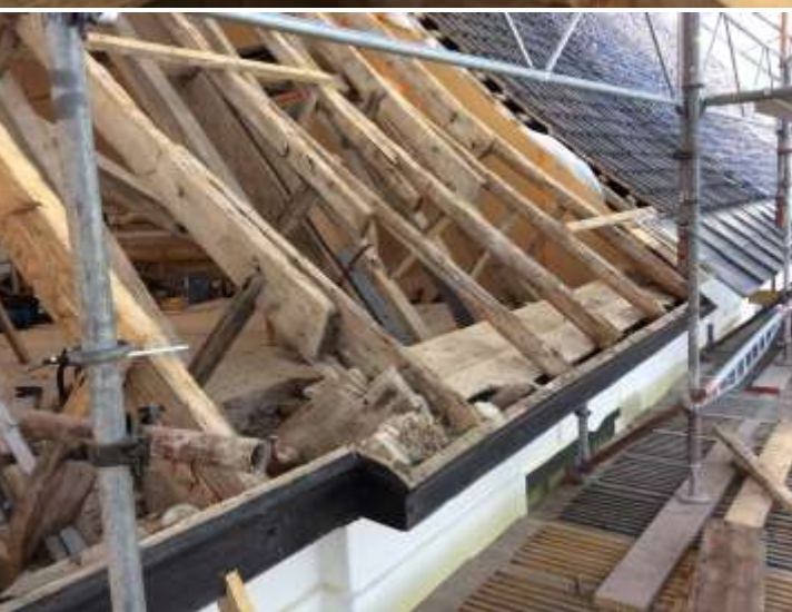
Nya fas-skarvade underbrädor på takfoten.
