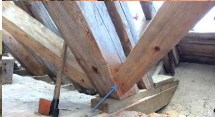
Nedre änden fogsågas och spikas med en 12" spik in i bockbenet.
