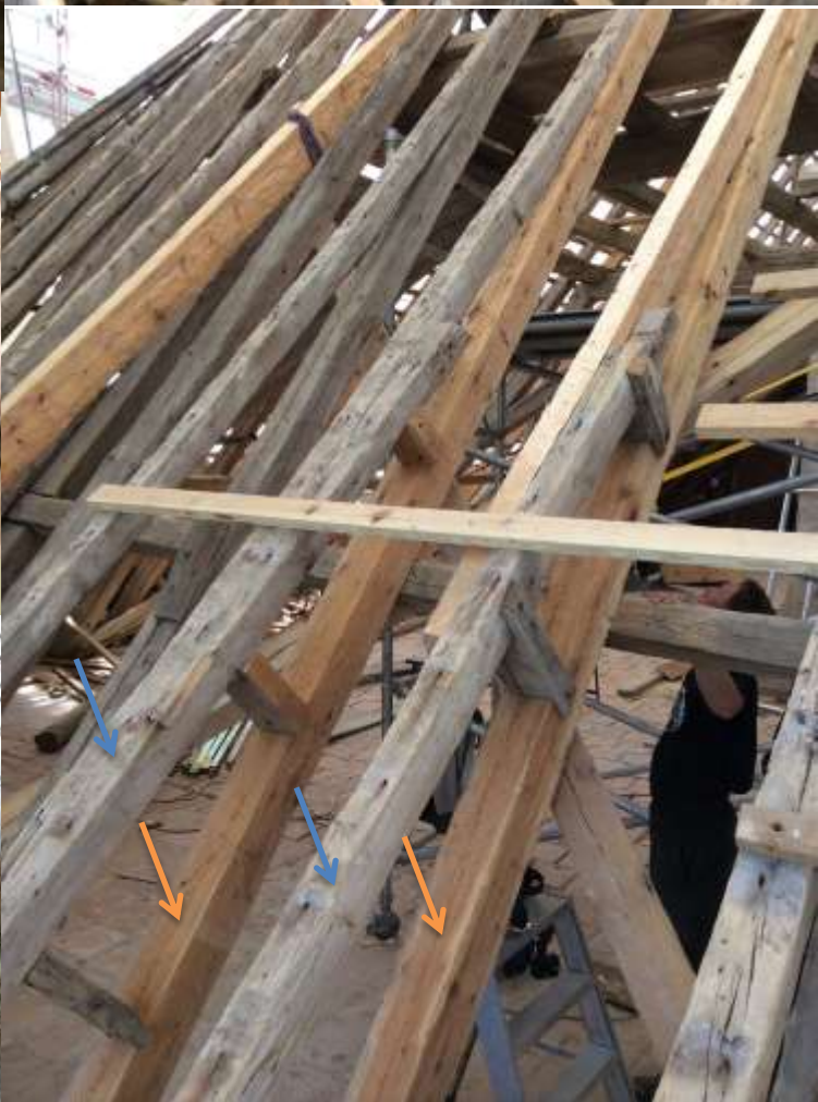
Blå pil är äldre påsalning och orange pil är högbenet på takstolen.
