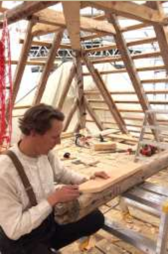
Tillpassning av takstolarnas hanbjälkar mot diagonalhanen.
