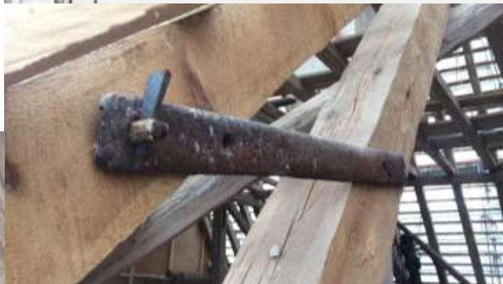
Äldre förlaga av hängseljärn där järnet är en återbrukad hjulring.
