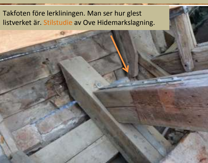
Ny kransågad påsadling med fläckspår "såghund" för sågbocken. Gammalt listverksjärn med nya spikar.
