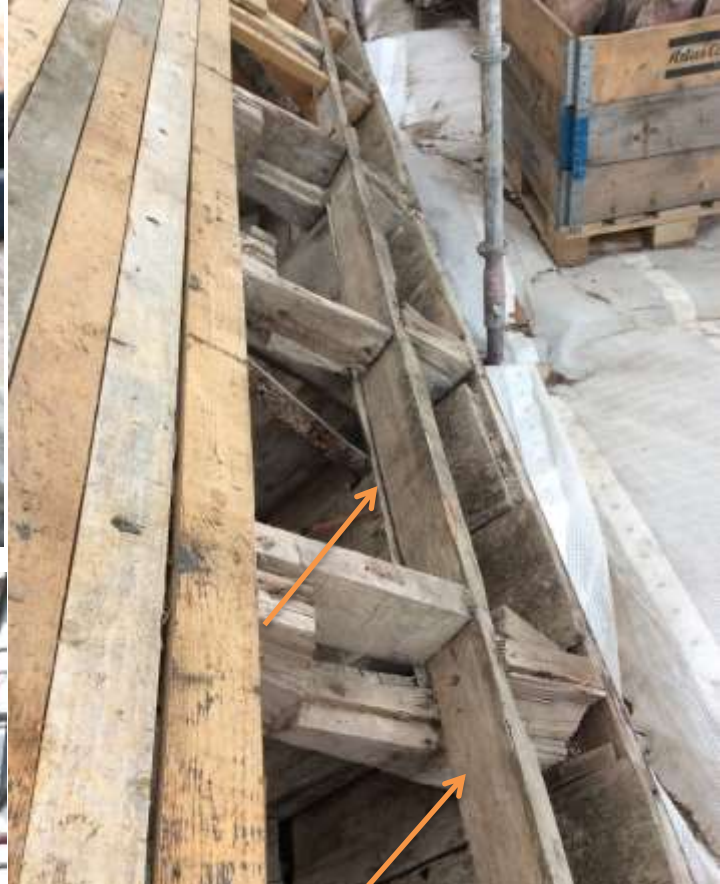
Den nerfällda vattenrännan i takfoten. Rester av originalbrädor finns på östra takfallet.
