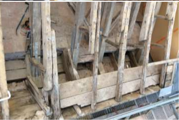
Takfotens utstickande del där slottsfasaden sticker ut har intressanta spår av att det kanske har varit ett trofékrön i trä på norra sidan. Fördjupade undersökningar behövs.
