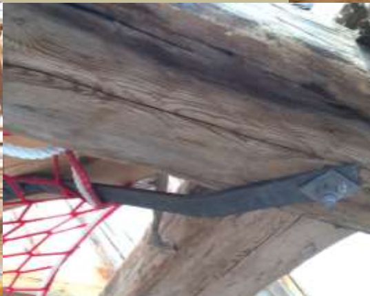
Dragjärn vid yttre mötet långrem/dia-hane som fästes i den befintliga bulten.
