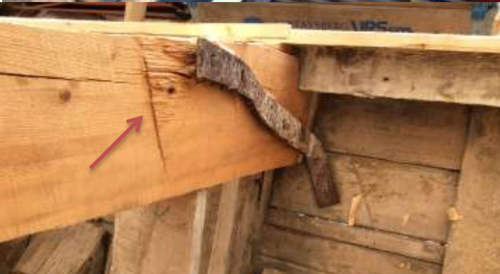
Ny kransågad påsadling med fläckspår "såghund" för sågbocken. Gammalt listverksjärn med nya spikar.
