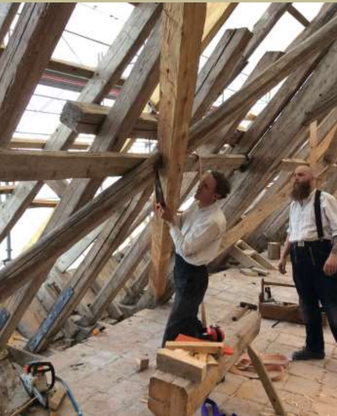
Nedre änden fogsågas och spikas med en 12" spik in i bockbenet.
