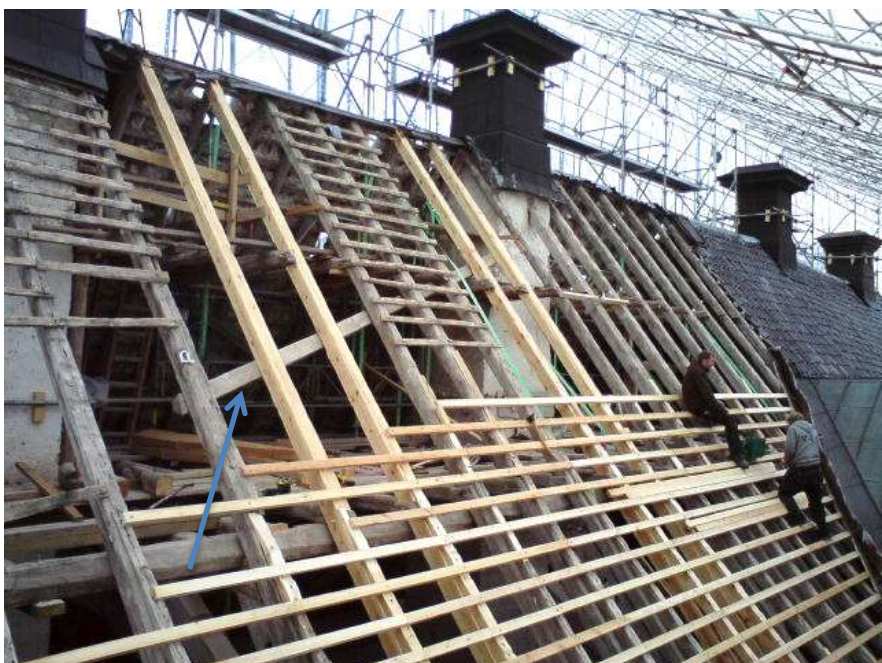
Tyvärr finns ingen bra bild på strävorna från årets renovering. Här ses 2010 års renovering och en av snedsträvorna i östra takfallet.
