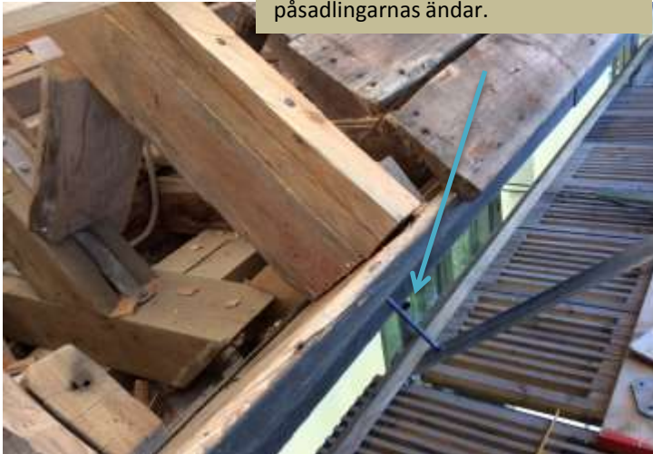
Nya 8" spikar igenom listverket in i påsadlingarnas ändar.
