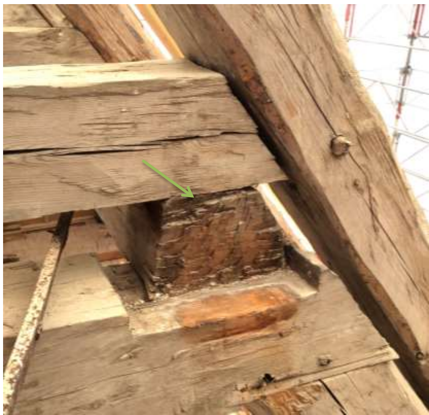
Bilderna visar Mattias och Tobias arbete med långremmarna. Med skruvstämp lyftes alla takstolarna individuellt för att frilägga långremmen.
