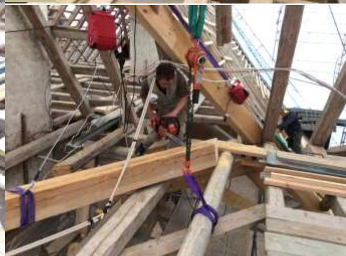
Mötet mellan långrem, bocken och gradsparren kräver precision för att krafterna skall gå rätt väg.
