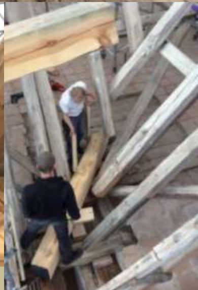
Tobias Ed arbetar med tassens undersida, med 14 olika kontaktytor som skall passas in med millimeterprecision mot de mötande bjälkarna.
