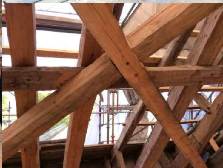
Nedre änden fogsågas och spikas med en 12" spik in i bockbenet.
