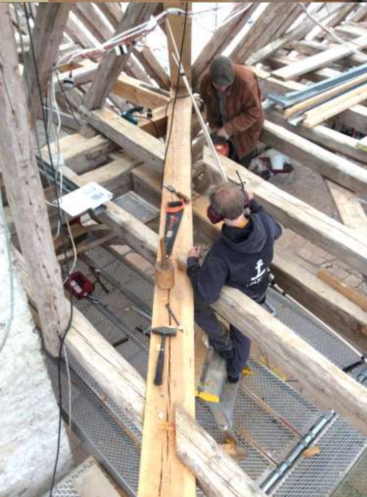
Tillpassning av takstolarnas hanbjälkar mot diagonalhanen.
