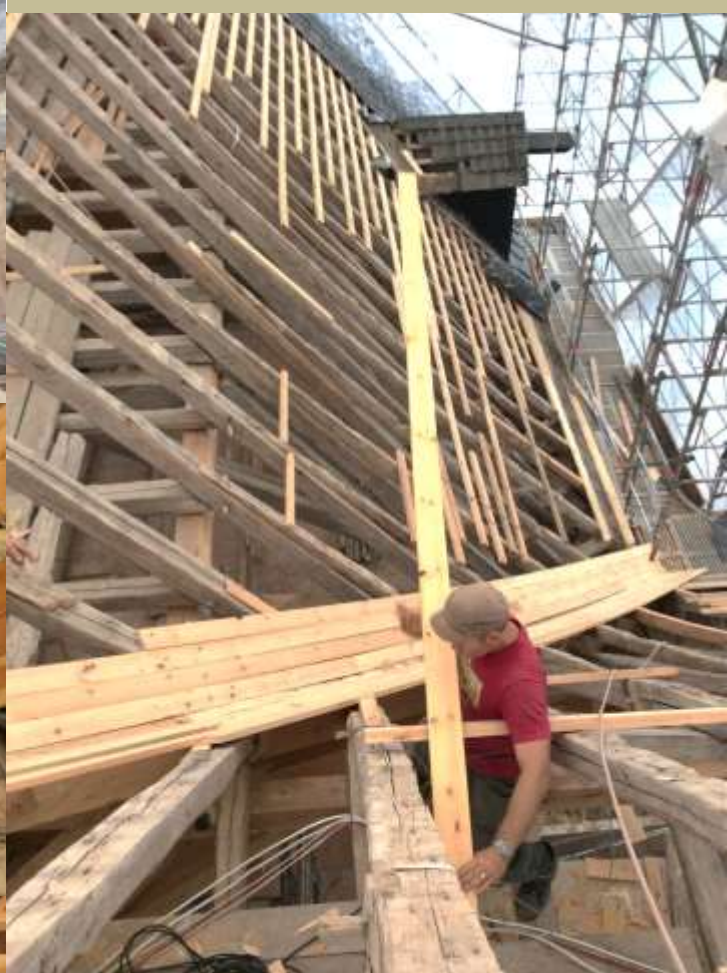
Vinkelrännan har en långbøj lite som språnget på en träskuta fast med spanten på utsidan. Det var svårt att böja brädorna och hugga ner dem i takstolarna till rätt nivå mot den mötande läkten. Millimeterpassning så plåtslagaren skulle bli glad.
