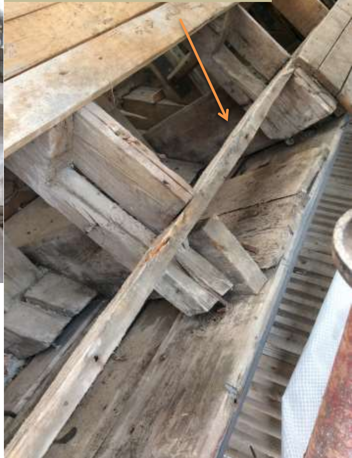
Fräschaste originalknuten vid murrem, bindbjälke, högben vi har funnit. Här ser man hur knutningen är gjord ner mot murremmen .
