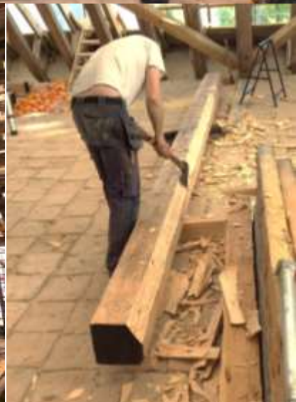
Bilderna visar Mattias och Tobias arbete med långremmarna. Med skruvstämp lyftes alla takstolarna individuellt för att frilägga långremmen.
