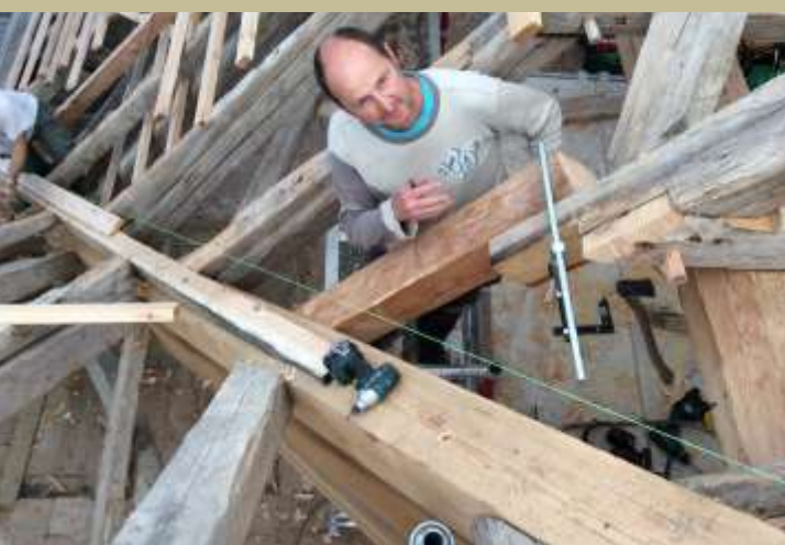
Johan skarvar ett anslutande högben till gradsparrens övre del.
