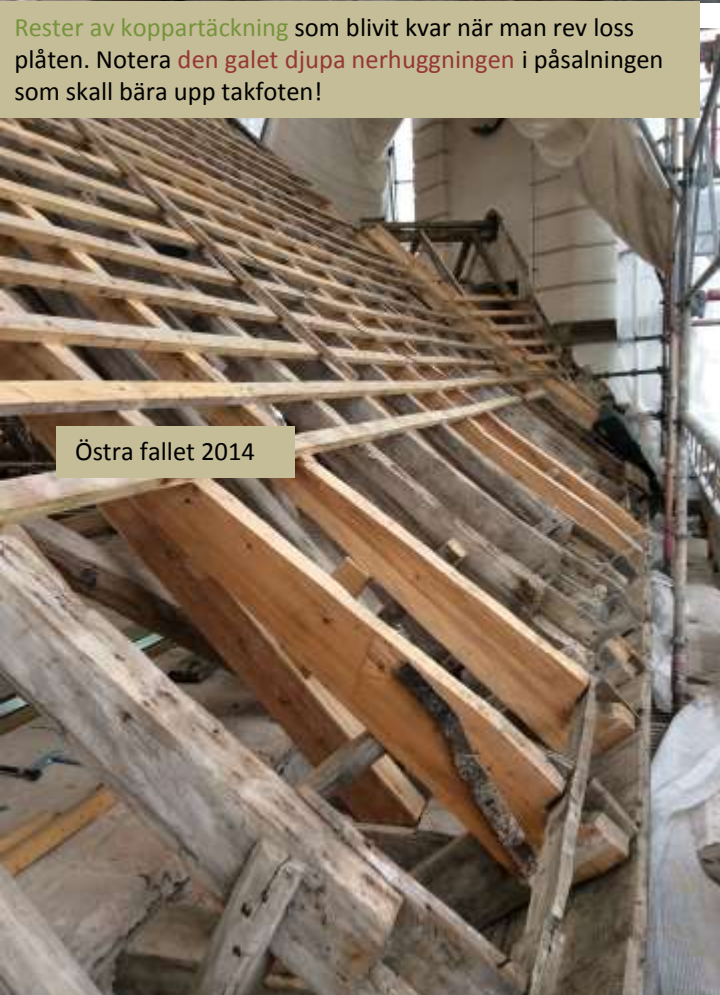
Den nerfällda vattenrännan i takfoten. Rester av originalbrädor finns på östra takfallet.
