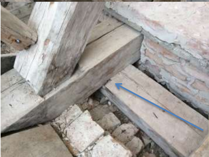
Fräschaste originalknuten vid murrem, bindbjälke, högben vi har funnit. Här ser man hur knutningen är gjord ner mot murremmen .
