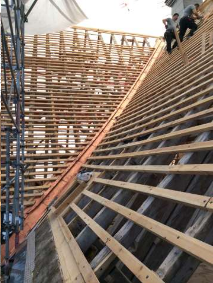
Vikens plåt och deras arbeten med vinkelrännan, takluckan och takfotsplåten. Fredrik var ansvarig plåtslagare på plats. En duktig sådan.
