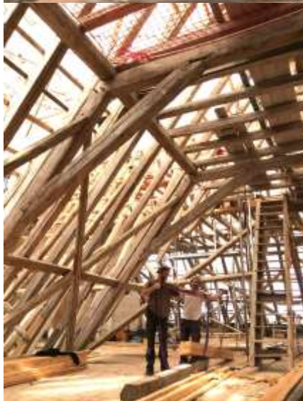
Bilderna visar Mattias och Tobias arbete med långremmarna. Med skruvstämp lyftes alla takstolarna individuellt för att frilägga långremmen.
