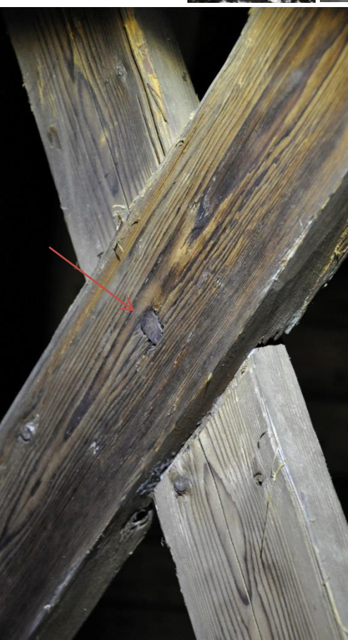
Urtag för kryss i tornbenen som aldrig monterats.
