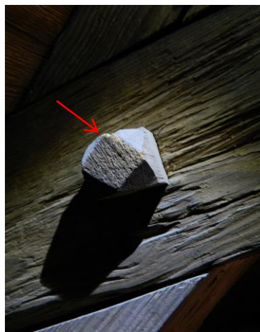
Dymling ändkapad med såg.
