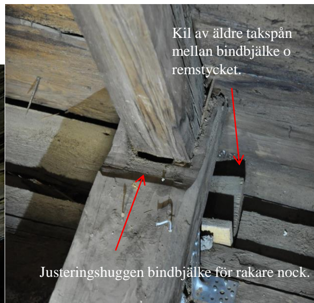
Dymling ändkapad med såg.
