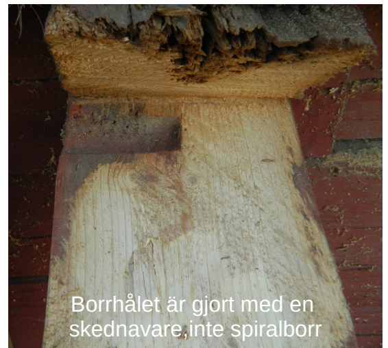
Borrhålet finns i alla takstolar och betyder att Tillverkningen skett utifrån en mall.
