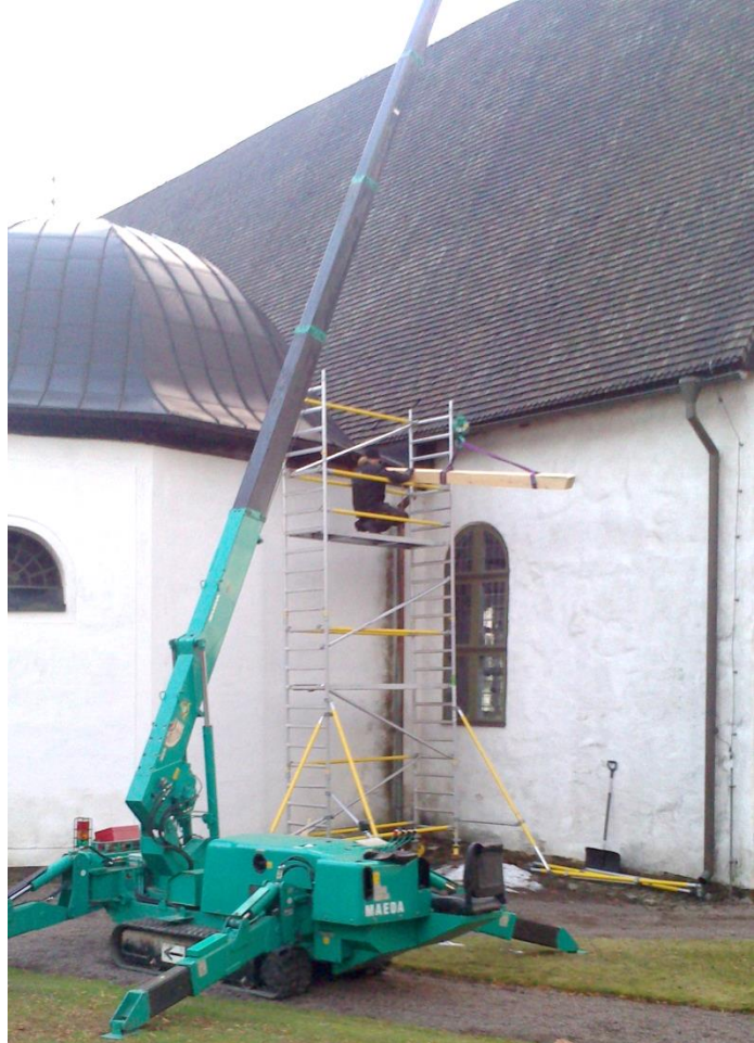
Nya bindbjälken till späntakstolen winchas in under takstolarna
