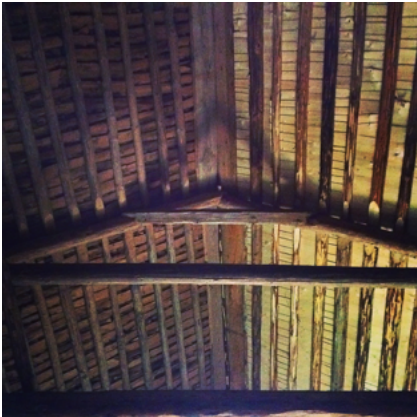
Till vänster syns det gamla taklaget och till höger det nylagda.
